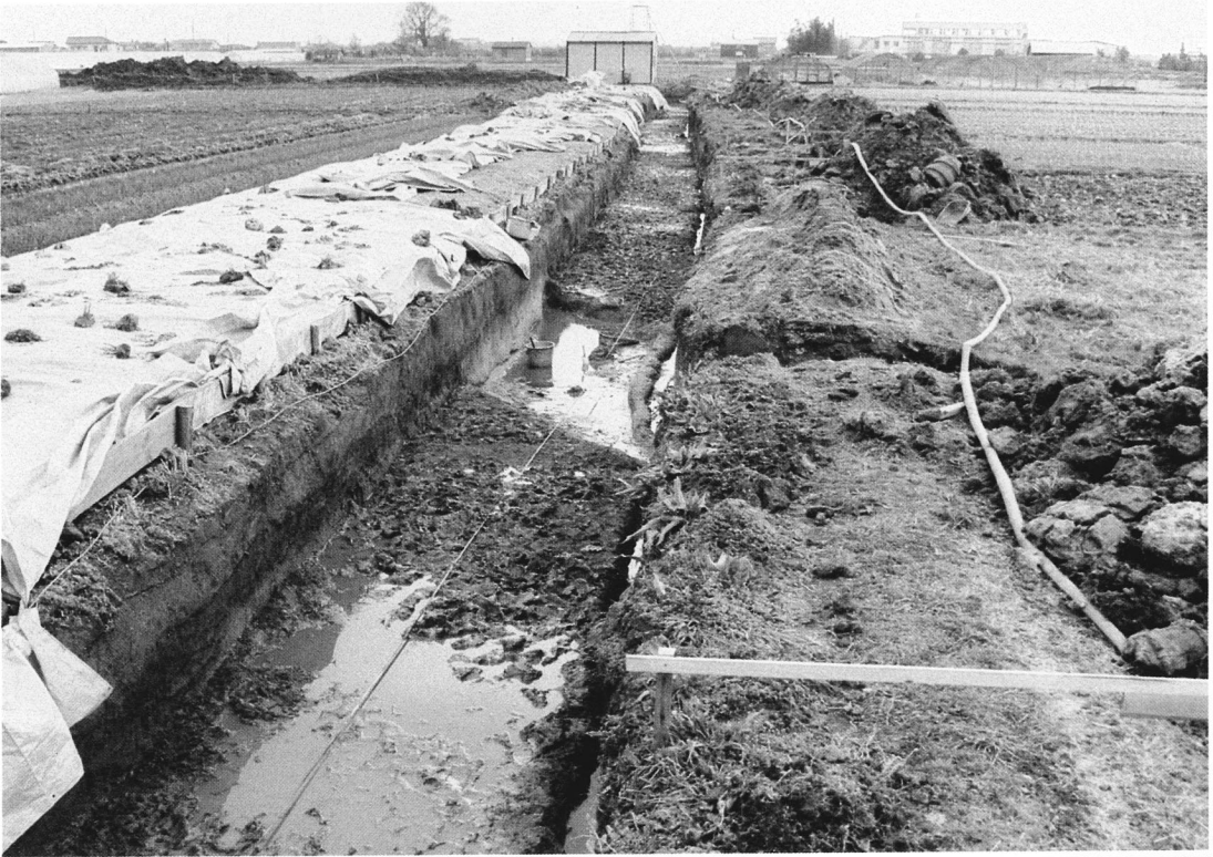
a. トレンチ全景（北から）
