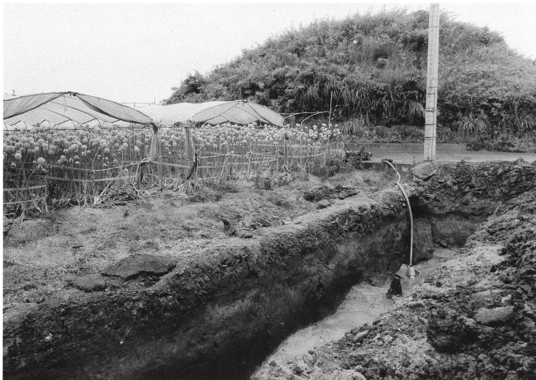
a. トレンチ全景 (西から)
