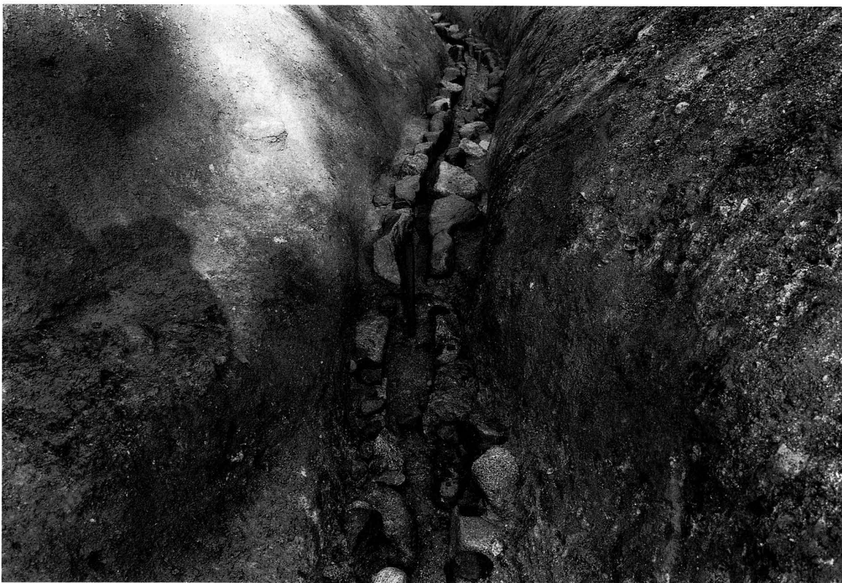
2. 同上 蓋除去後（木杭から奥が東排水溝）
