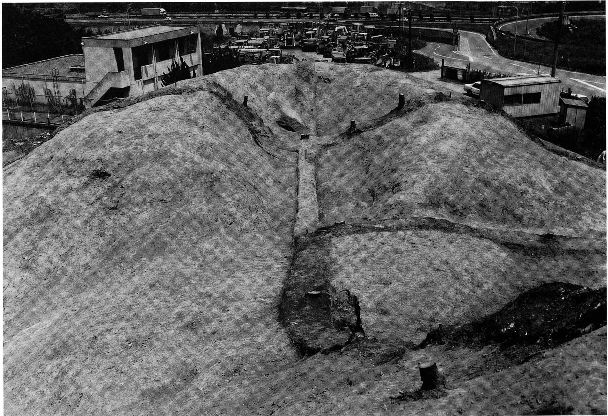
2. 表土除去後の現状
