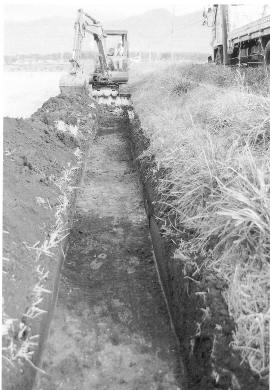
鑄師屋遺跡Ⅲ調査風景（南から）
