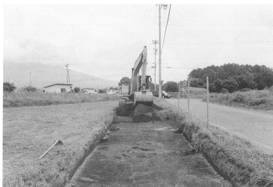
下曽根遺跡Ⅶ表土除去作業（西から）
