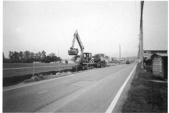
曾根城遺跡Ⅳ表土除去作業（南から）
