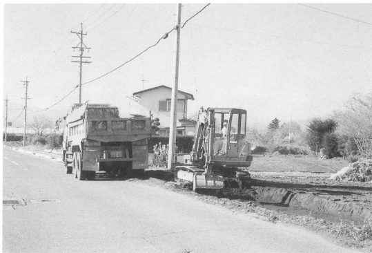
下曾根遺跡Ⅷ H15年度表土除去作業（南東から）
