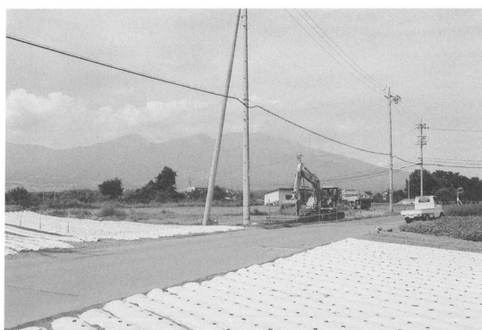
下曽根遺跡Ⅶ埋め戻し作業（南西から）
