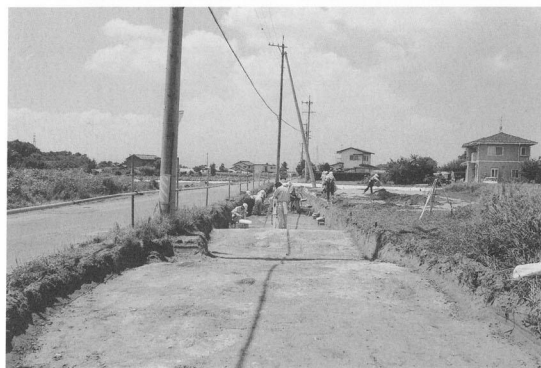
下曽根遺跡Ⅶ調査風景（東から）
