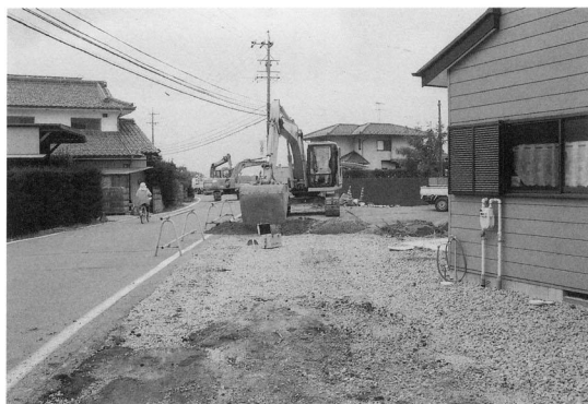
前田遺跡V調査風景 (北から)
