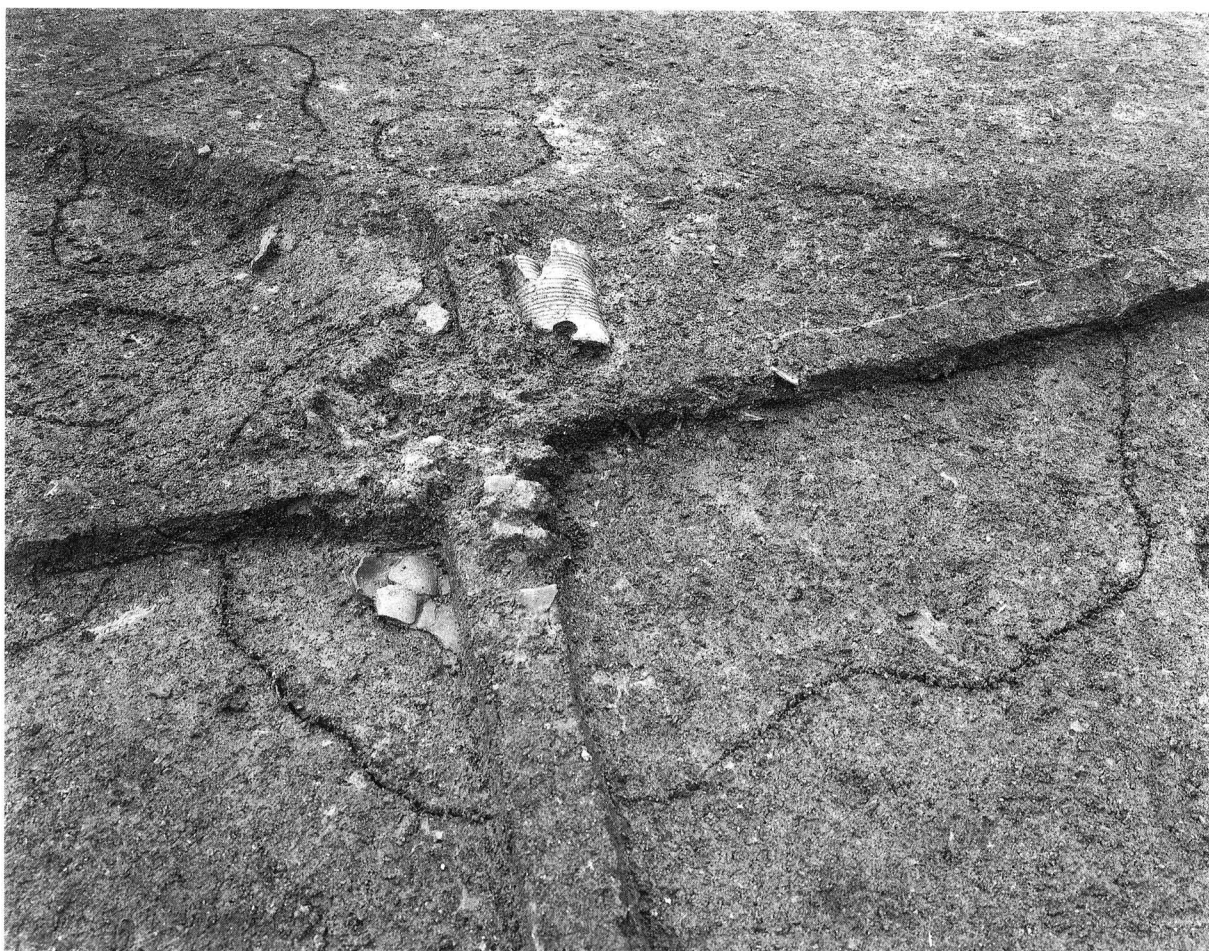
2. SK-108上層 検出状況
