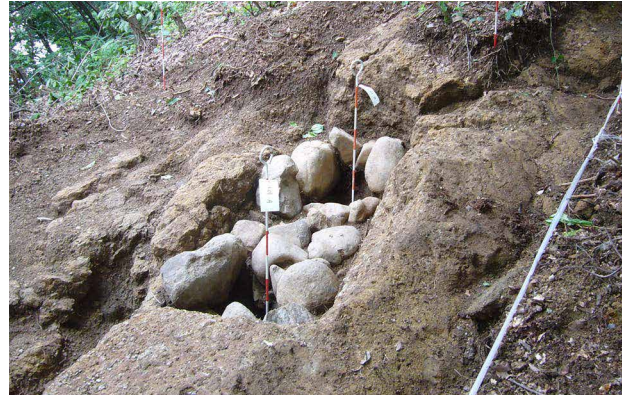
送電線の電柱を埋設した穴
