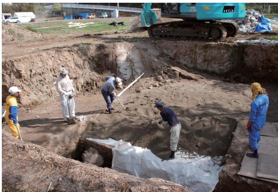
保護砂による埋め戻し
