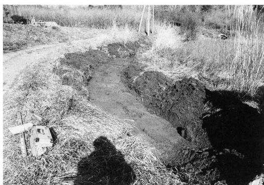
試掘トレンチ
