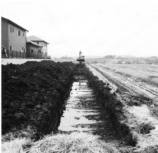
試掘トレンチ
