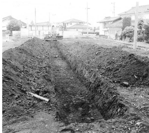
試掘トレンチ
