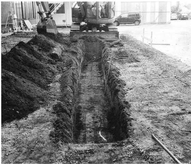
試掘トレンチ
