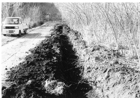
試掘トレンチ
