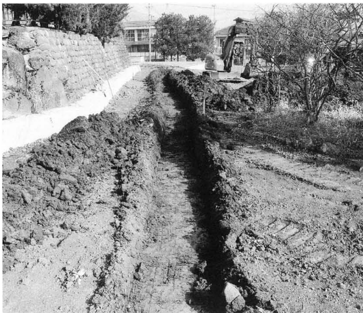
試掘トレンチ
