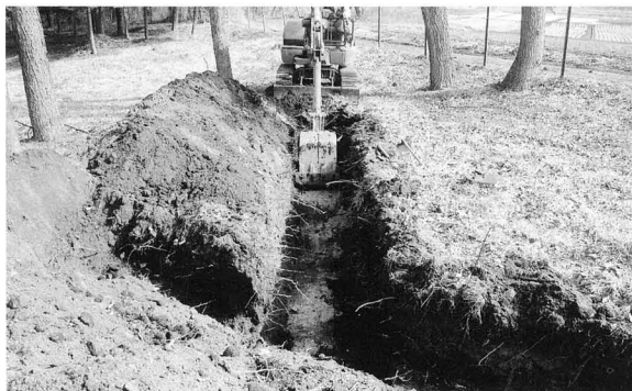
試掘トレンチ
