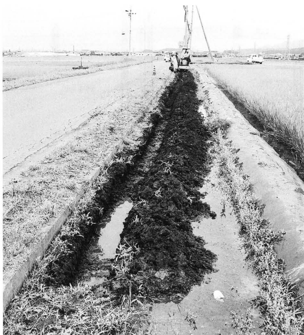
試掘トレンチ
