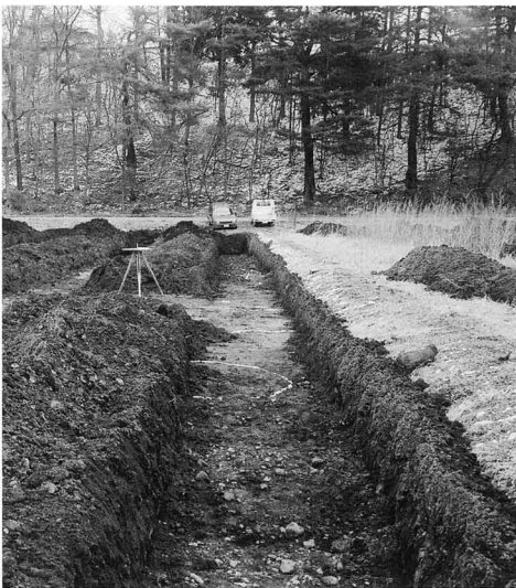
遺構検出状況
