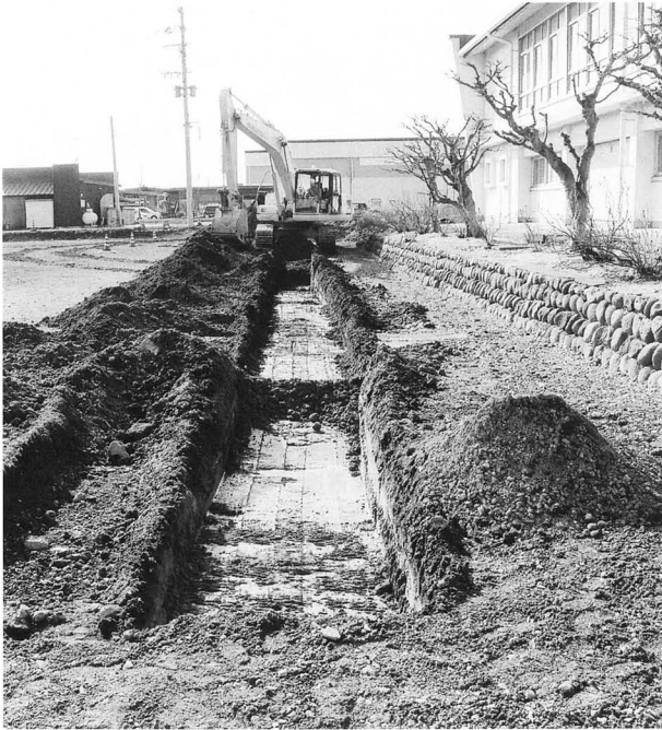
試掘トレンチ
