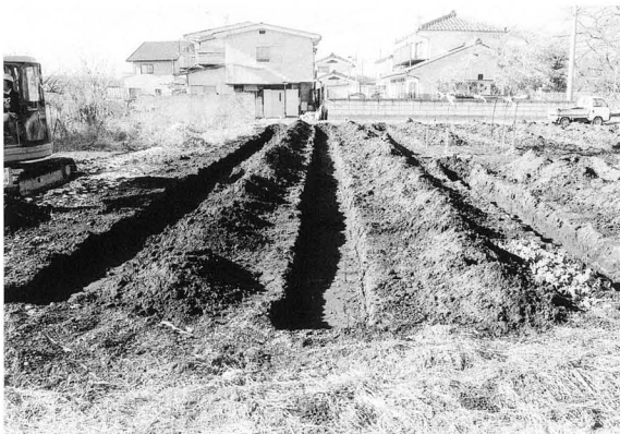
試掘トレンチ
