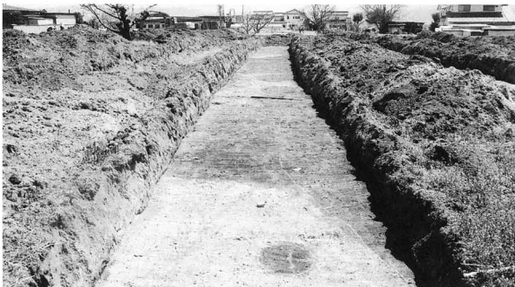
試掘トレンチ
