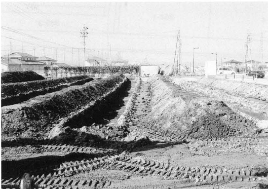
試掘トレンチ
