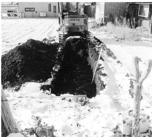
試掘トレンチ
