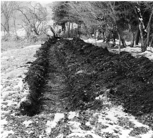
試掘トレンチ
