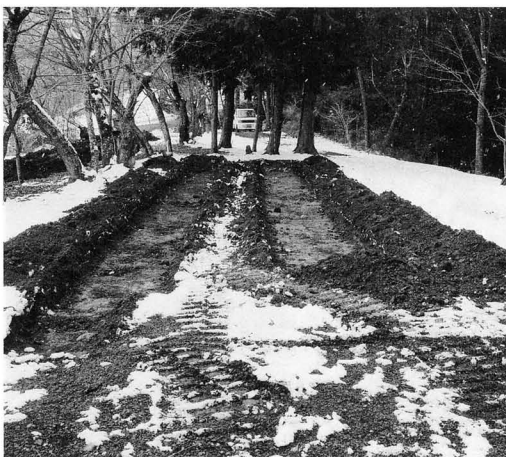
試掘トレンチ
