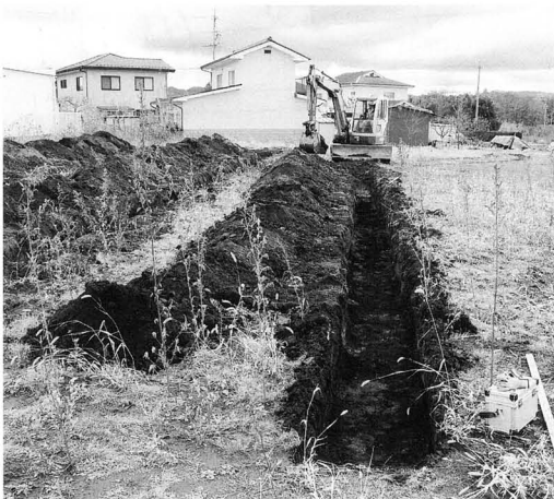
試掘トレンチ
