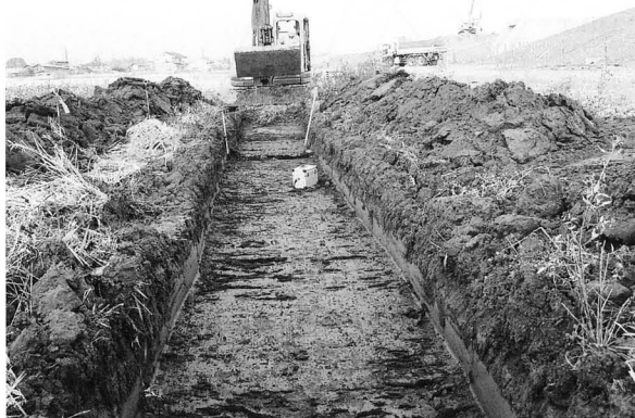
試掘トレンチ
