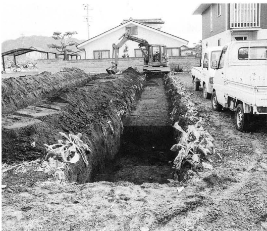
試掘トレンチ
