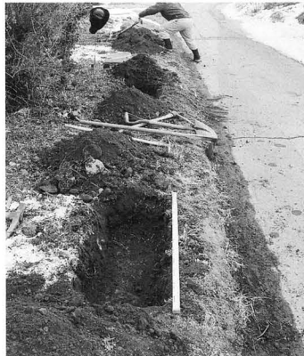
試掘トレンチ
