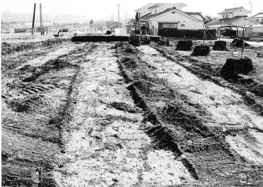
試掘トレンチ
