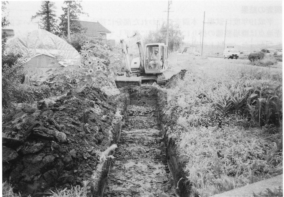
試掘トレンチ
