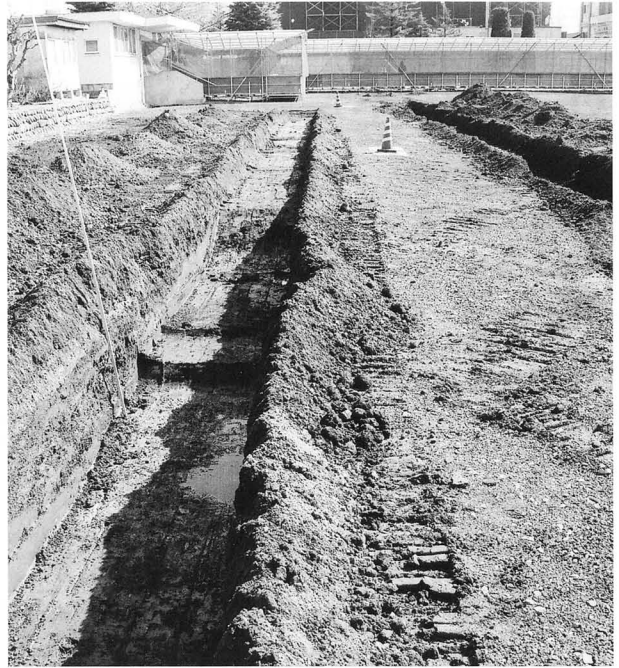
試掘トレンチ
