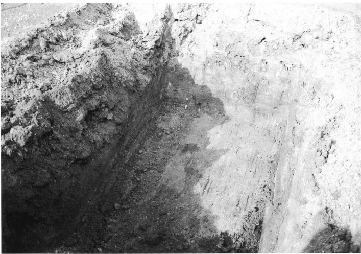
試掘トレンチ
