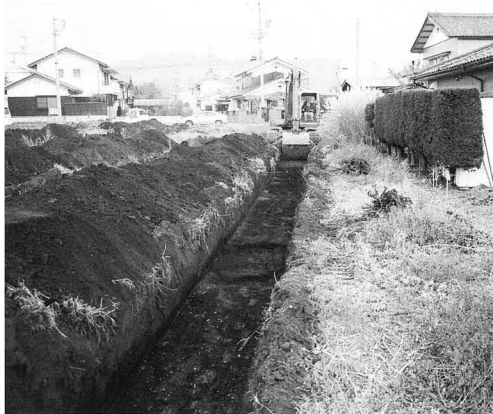
試掘トレンチ
