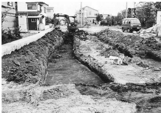
試掘トレンチ
