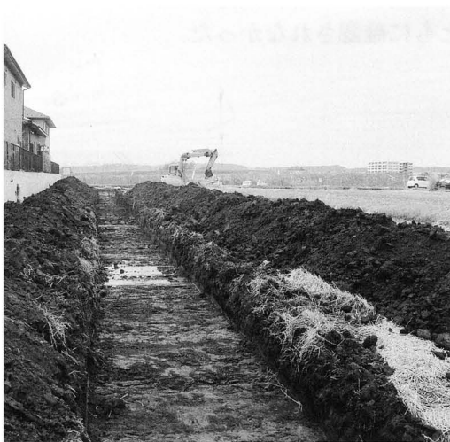
試掘トレンチ
