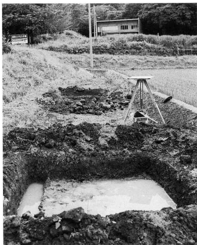
試掘トレンチ
