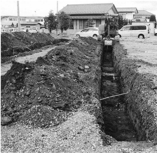
試掘トレンチ
