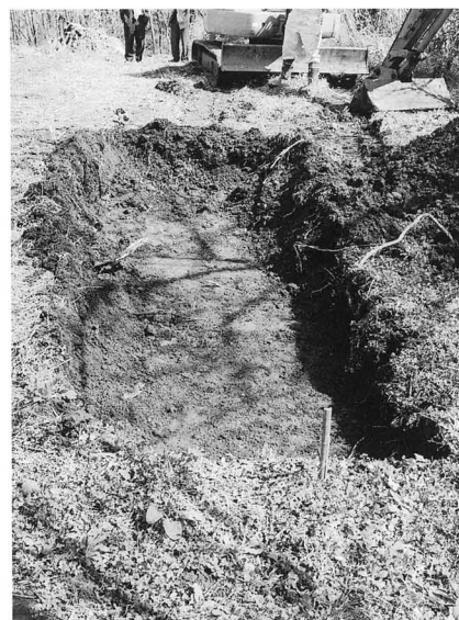
試掘トレンチ
