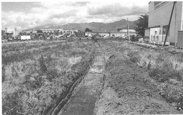
中原遺跡群(隣接)調査地点 (南方から)
