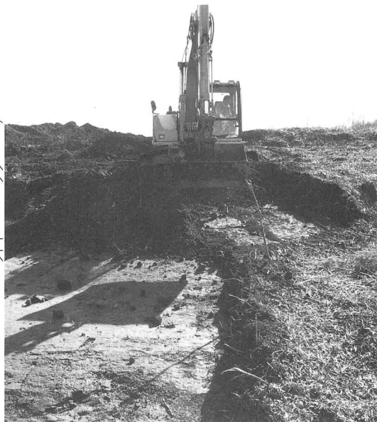
トレンチ掘削状況図
