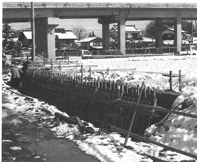
工事風景（西より）
