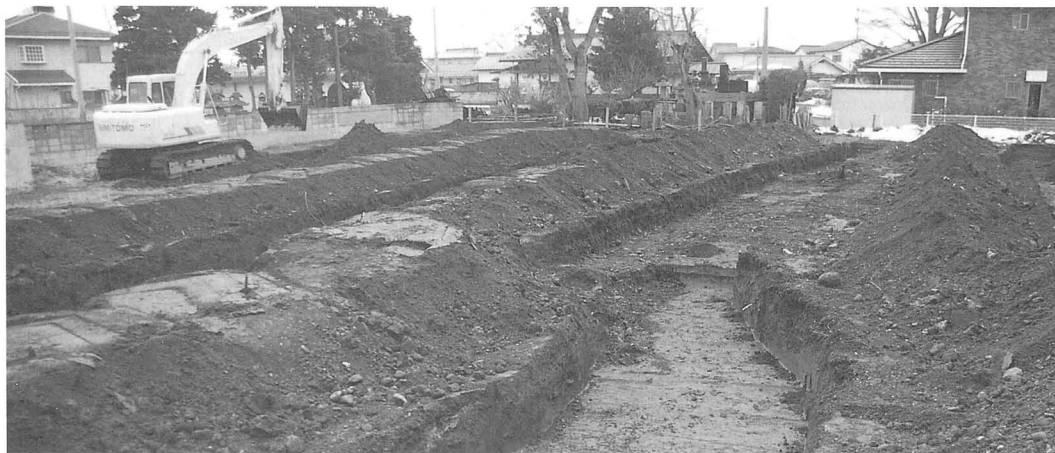
白拍子遺跡群トレンチ掘削状況（北より）
