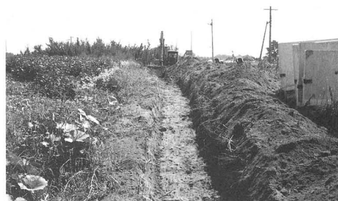
藤塚遺跡 東側調査トレンチ (西から)
