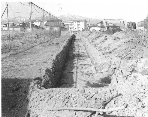
Bトレンチ (南方より)
