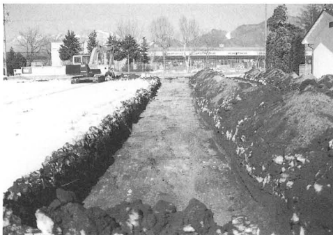
戸坂遺跡群 調査トレンチ (南から)
