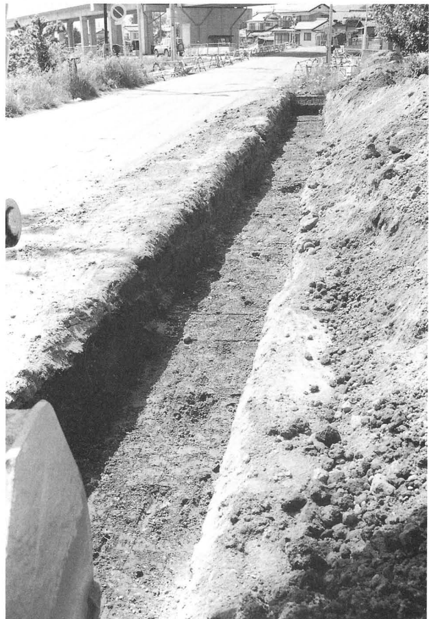
前田遺跡群 2 調査地点近景 (南方から)
