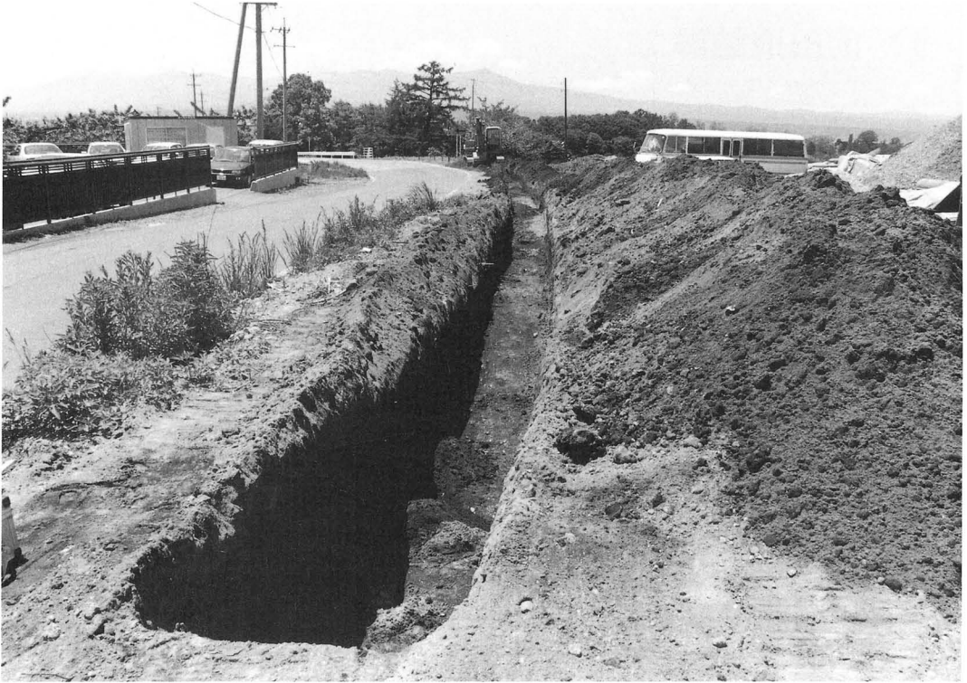
トレンチ掘削状況（北より）
