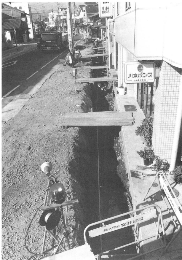
工事状況（東より）
