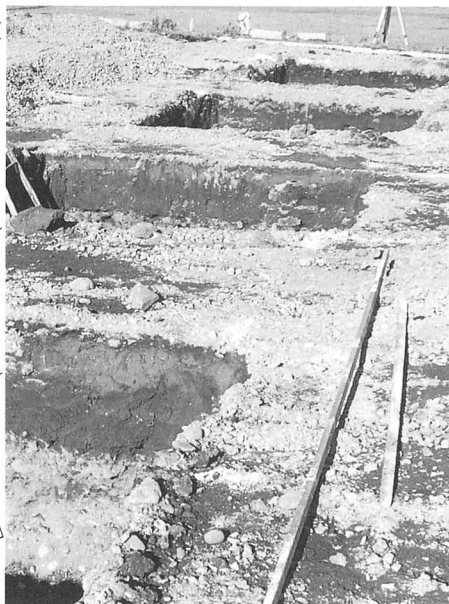
建物基礎部分掘削状況 (南より)
