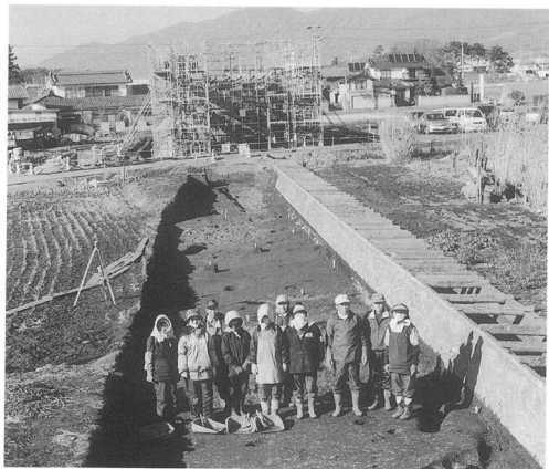
南側調査区 奥の構造物が「中部横断自動車道」
