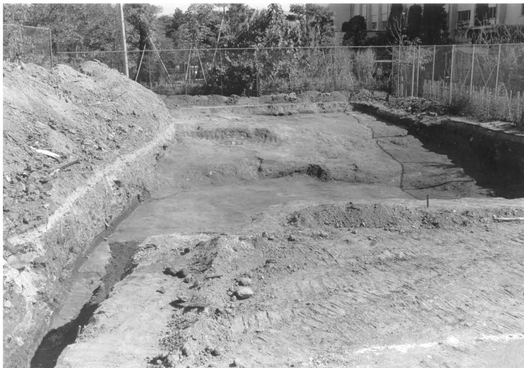
1. 調査区（部室棟建設予定区）
