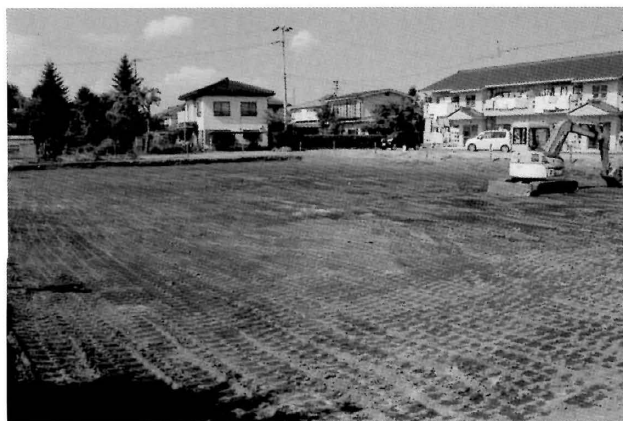
H22年度調査区埋め戻し状況
