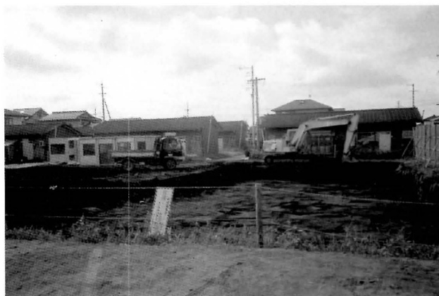
H22年度調査西区表土除去作業
