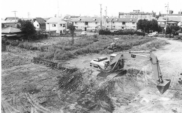
平成6年度 表土の除去（北西から）
