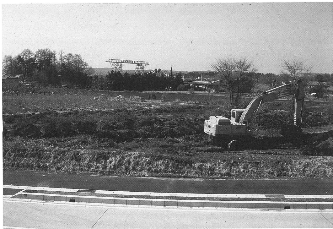
トレンチ設定状況（東方より）
