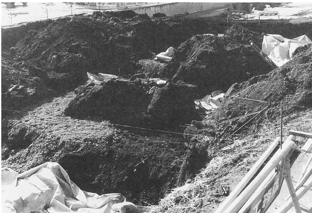
基礎工事部分（北方より）
