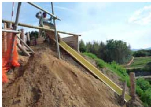
コンクリートシューターを用いたの排土処理
