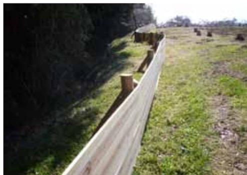
調査前に設置した土砂流出防止柵
