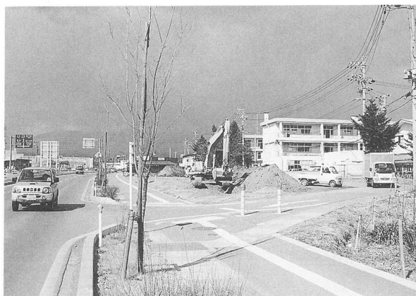
調査状況（南方から）
