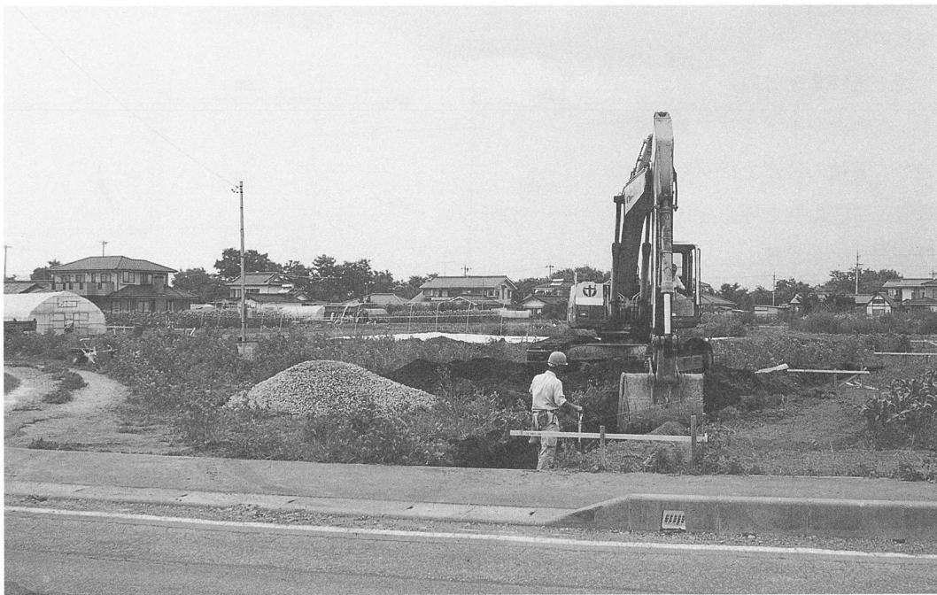
基礎部他掘り下げ立会風景（南から）
