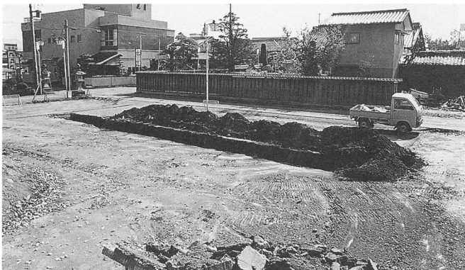
C トレンチ掘削状況 (北から)
