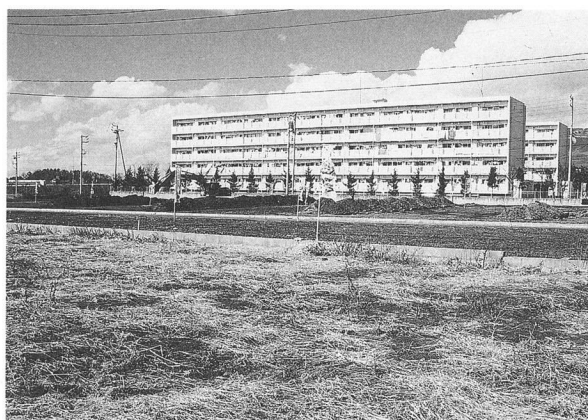
調査状況(南方から)
