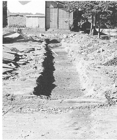
A トレンチ掘削状況 (東から)
