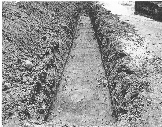
トレンチ掘削状況 (北西から)
