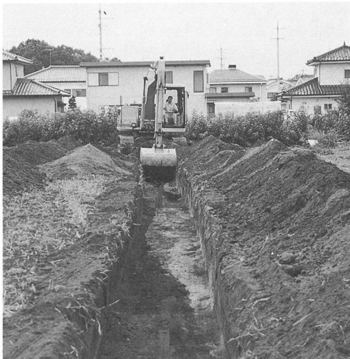
調査風景 (北から)
