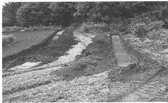
トレンチ掘削状況 (北から)
