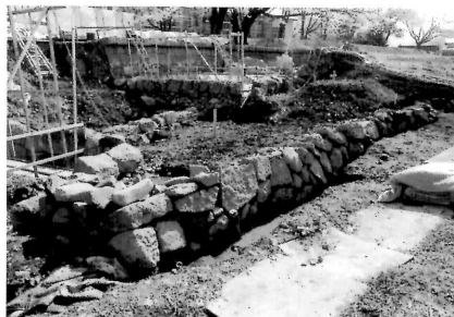
南裾石垣（南西より）
