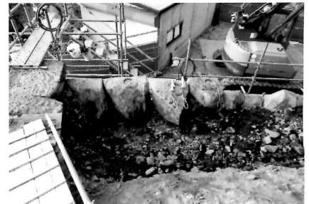
出隅部の天端石をはずしている
