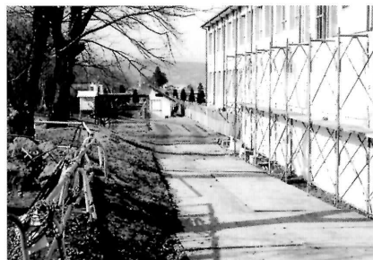
仮囲いと進入路
