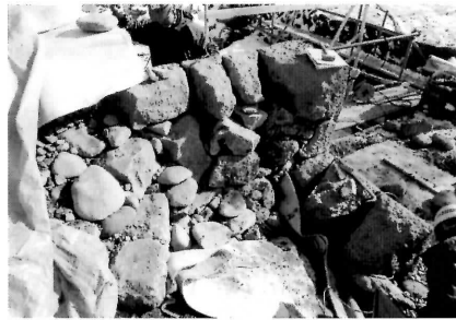
積み工 G面・D面出隅部裏側
