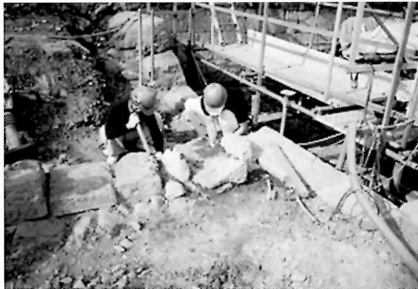
石組み暗渠の東端に粘土を充填
