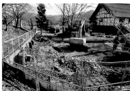
旧プール撤去 南より
