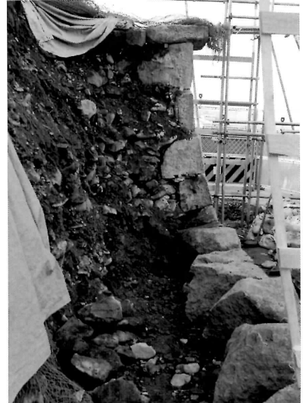
出隅部の裏込め 昭和修理時にクラッシュラン(中碎・細碎)を使用、かつ締め固めが不十分。
