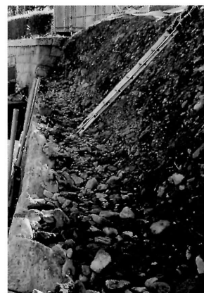
天端石解体後中石を見る（西より）
