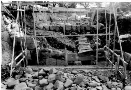
石組み暗渠と下流B面にある排水口
