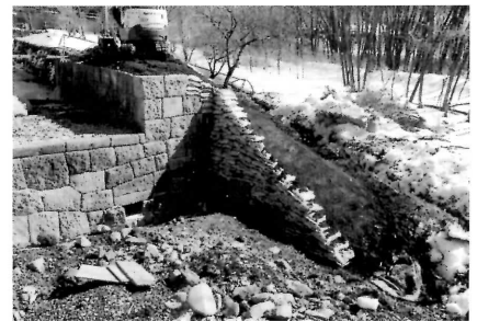
C面の土嚢養生と上面の土盛り
