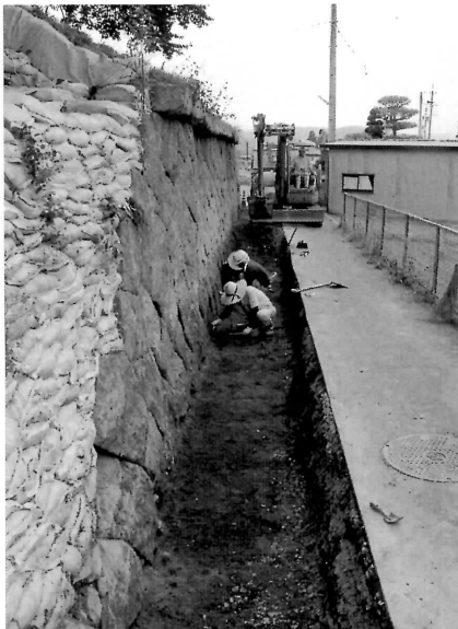
第Ⅱ工区の根石前面を掘り下げる。N64～N68の根石前は碎石となっている。根石の前面に粘土層はなかった。西端の出隅部3石の根石の下は礫混じりの粘土である。
