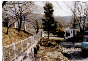
旧プール撤去
