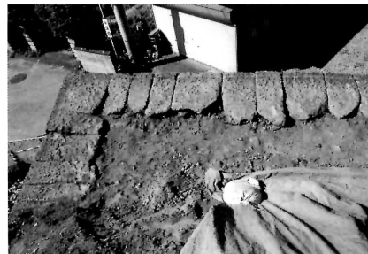
出隅部の跳ね出し石 上部の土塁を解体して石を出している。
