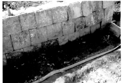
E面側通水部掘り下げ
