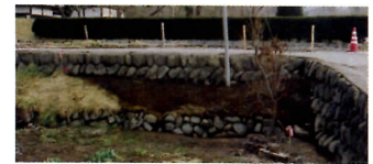
市道改良舗装工事：上が現道路面、下が旧道路面である。
