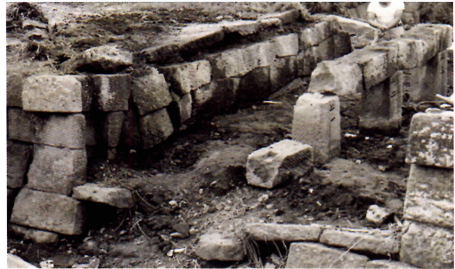
昭和 51 (1976) 重要文化財等保存整備工事 ⑦黒門石橋架替 解体中
