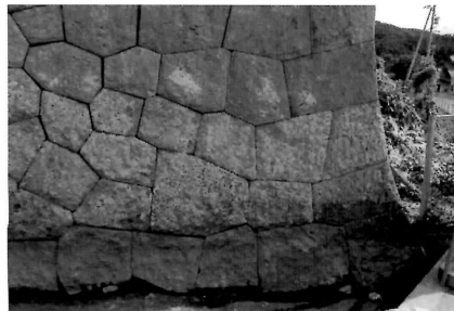
出隅部石垣 根石8石までは布積みになっている。ただし据え直されている。
