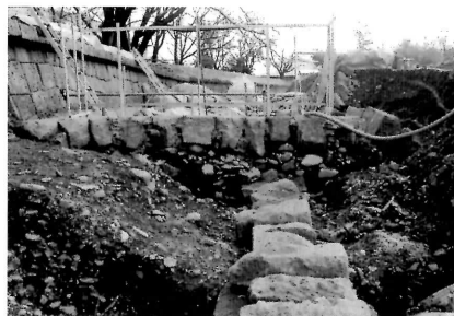
石組み暗渠とG面（西より）
