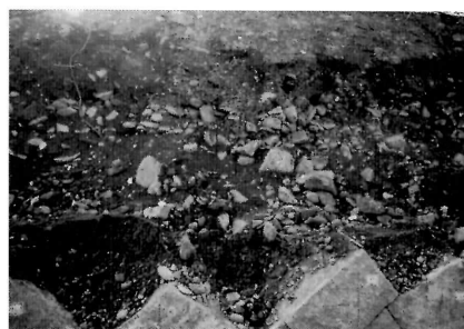
96～98裏込めクラッシャーラン
