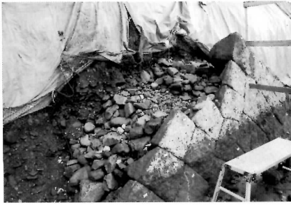
積み工 中石194・243付近
