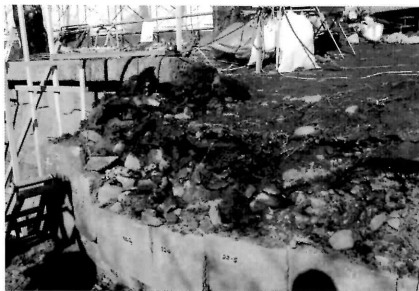
D面のD1石列除去後裏込め
