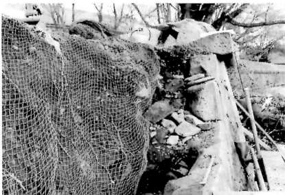
F面石垣解体と裏込め状況
