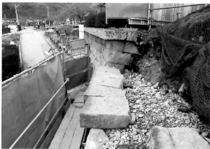
跳ね出し石石積み工
