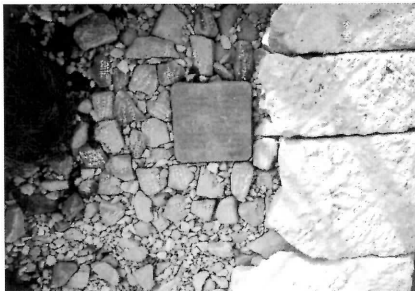
積み工 西端出隅に保存会の役員名を書いた石板と子供の夢を書いた栗石を入れる。
