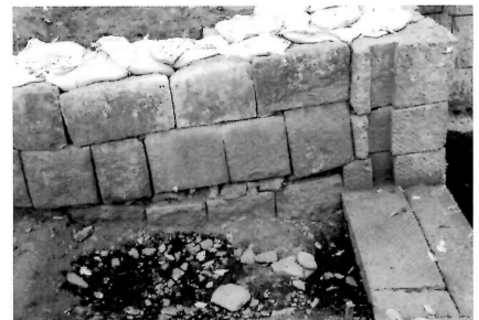
通水部D面石垣と堰板溝
