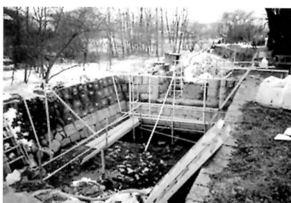
石垣解体仮遣り方（上流側）
