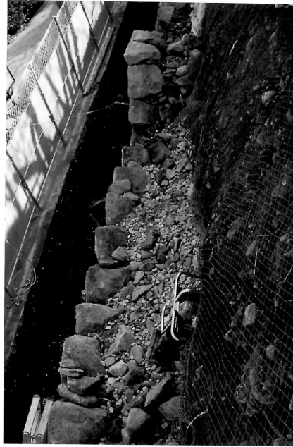
I 工区東の石積み工
