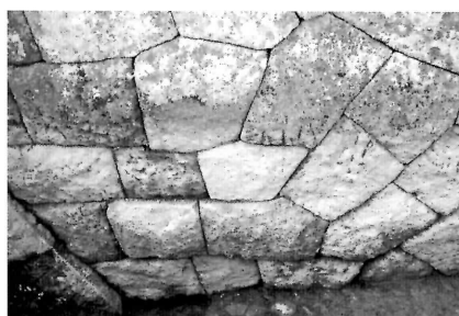
根石N1～N4付近亀甲崩しの布積み
