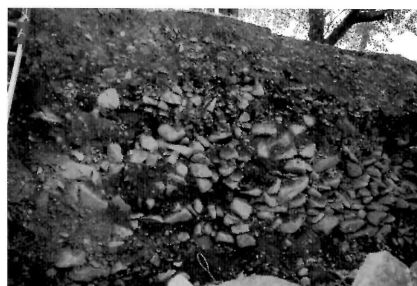
K1～K3の跳ね出し石と天端解体後の裏込め
