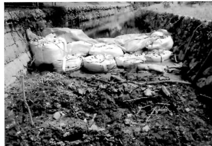
石垣修理前 上流側水替え工事
