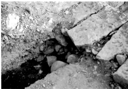
A面石垣裏込め
