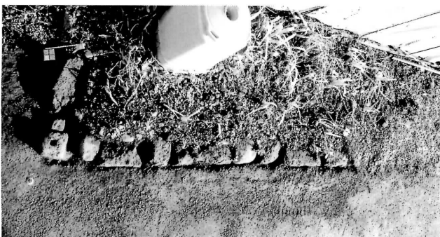
市道改良舗装工事 B地点 (南より)
