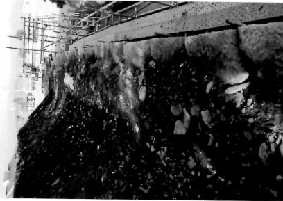
跳ね出し石を解体する。
