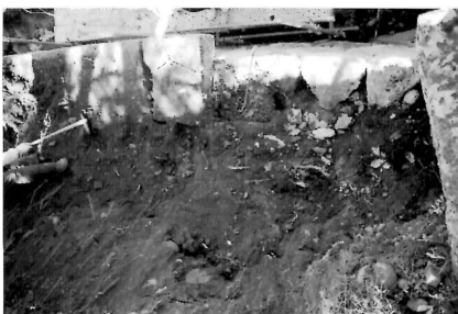
I 工区解体作業風景
