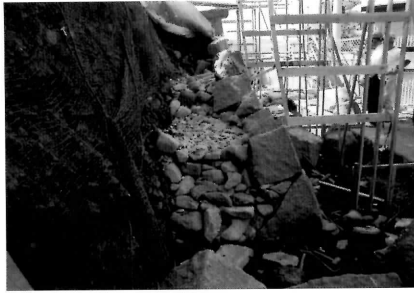
積み工 西端根石N61付近裏込め
