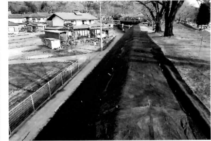
芝張り後泥を載せ寒冷沙で養生
