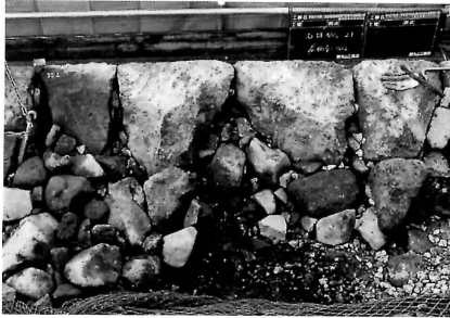
T23~T26石積み工
