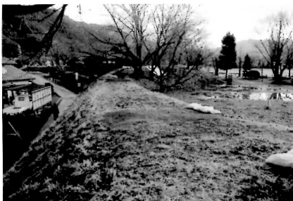
トレンチを埋め戻す
