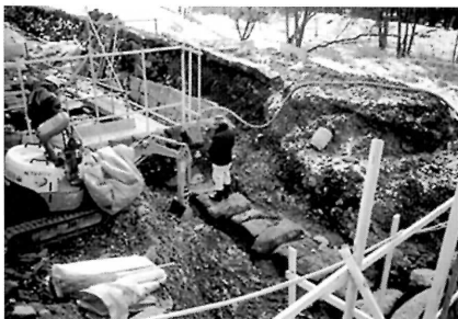
解体終了 石組み暗渠検出
