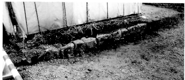
市道改良舗装工事 B地点 (南より)
