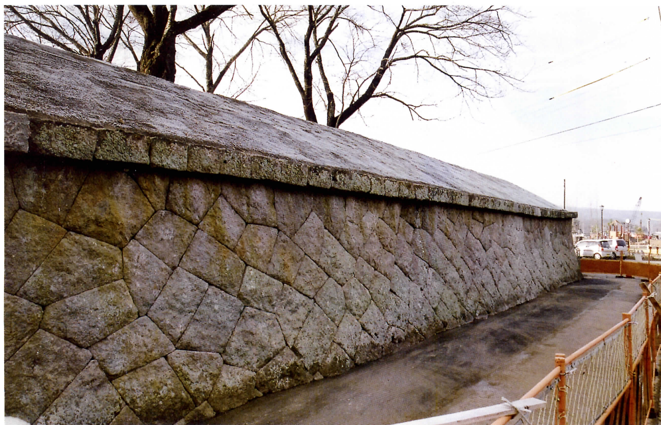
黒門西側石垣解体修理後 石垣西側全景（北西より） H22.12撮影
