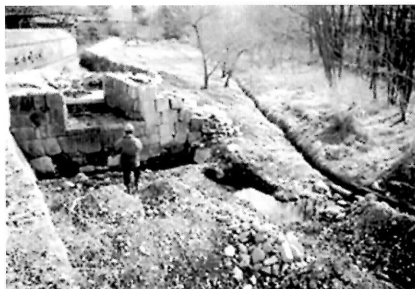
排水口石垣修理前 下流側
