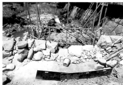
B面を積む、B6-6は新材にする
