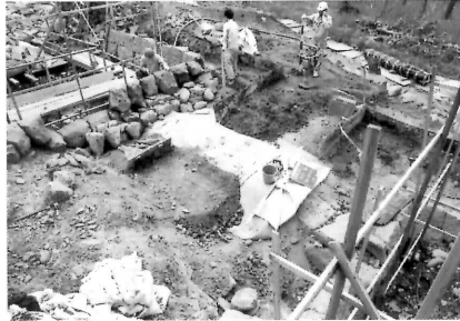
石組み暗渠を粘土・シートで覆う
