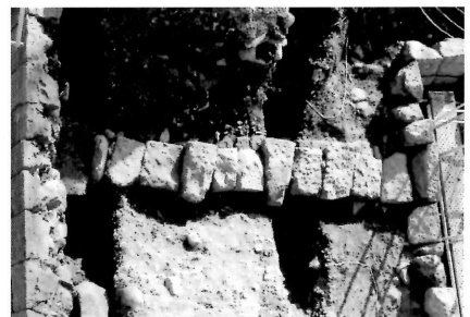
石組み暗渠（北より）
