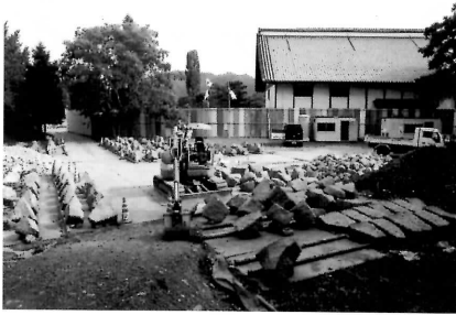
解体石材整理状況 解体した石材は部位ごとに整理している。採寸・記録や目視及び打音検査をしている。
