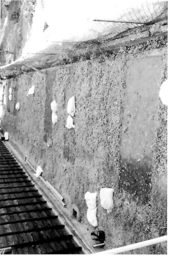
㊦トレンチ (北東より)
