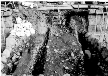
排水口（堰）北側
