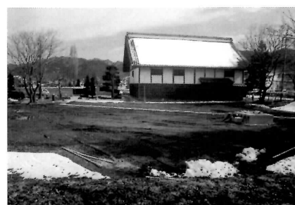
旧プール撤去後の整地 西より
