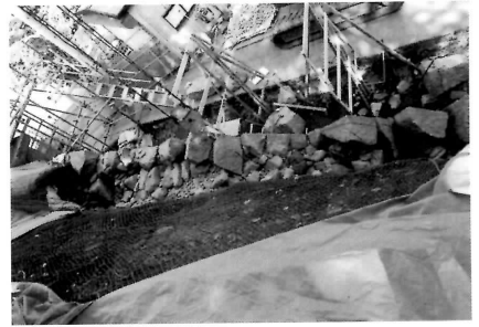
積み工 西端裏込め状況
