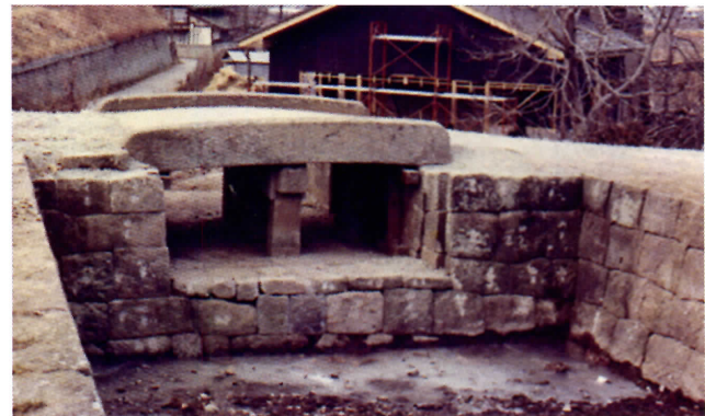
⑦黒門石橋架替工事 竣工
