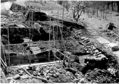
盛土を除去（西より）
