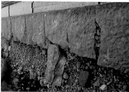
控えの短い跳ね出し石の裏の補強
