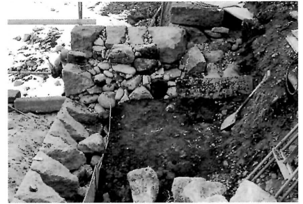
積み工 D面・B面出隅部裏側
