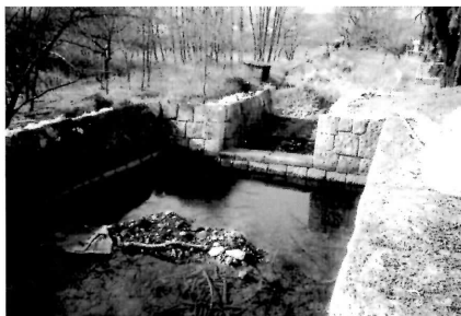
排水口石垣修理前 上流側
