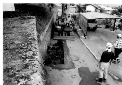
前面の道路を掘削して脚部を出す
