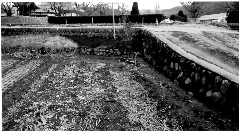
市道改良舗装工事 A地点（西より）
