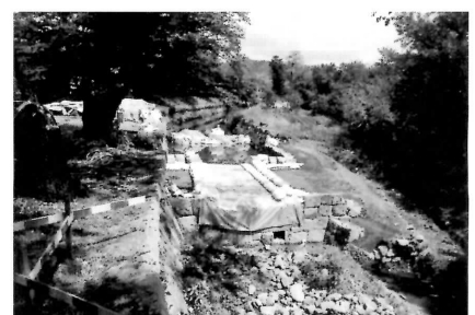
H19年度の工事を終了し、シート養生
