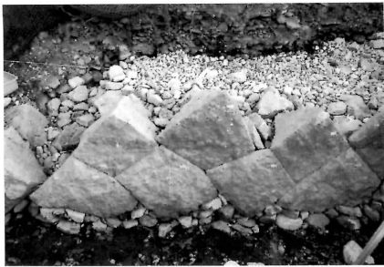
積み工 N37～N40下に栗石設置
