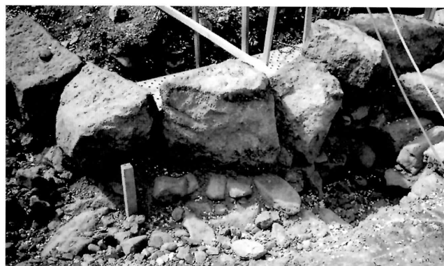
B面石垣 築城時の裏込め
