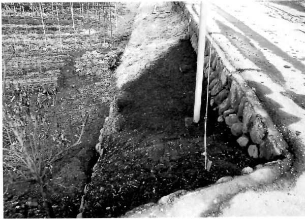
市道改良舗装工事 A地点旧道路面（南より）
