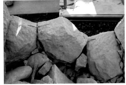
積み工 ステンレス棒でジョイント 中石214・213・212
