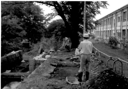
北岸土塁上面表土除去
