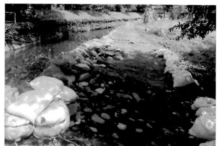
南岸H面土塁表土除去（西より）
