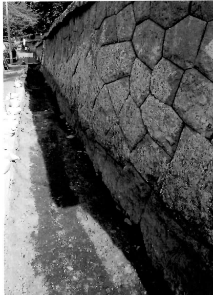
第Ⅱ工区の根石前面を掘り下げる。N64～N68の根石前は碎石となっている。根石の前面に粘土層はなかった。西端の出隅部3石の根石の下は礫混じりの粘土である。
