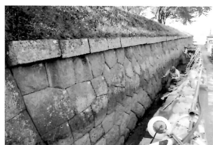
黒門西側石垣 解体準備
