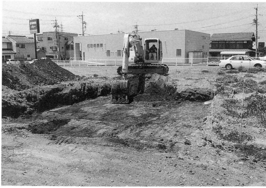
写真6 重機で表土を剥ぐ(東より)
