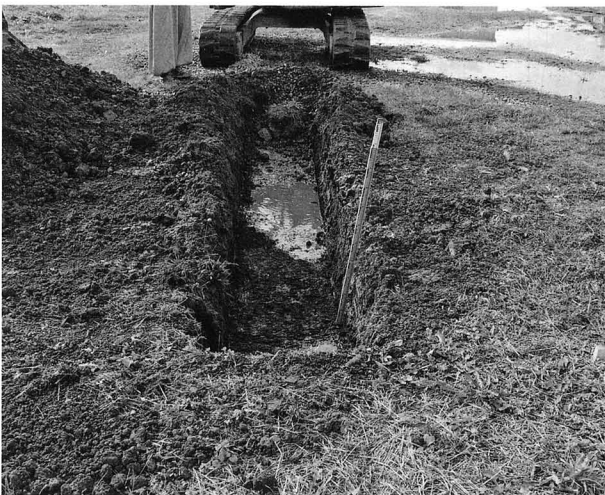
試掘トレンチ
