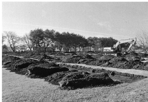
試掘トレンチ
