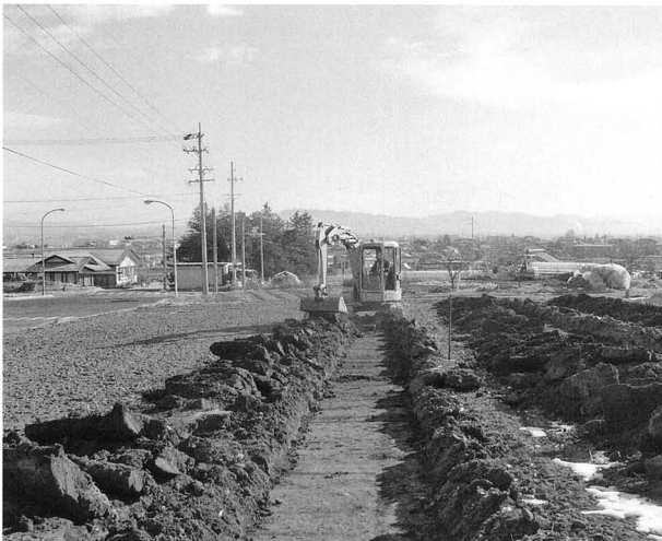
試掘トレンチ
