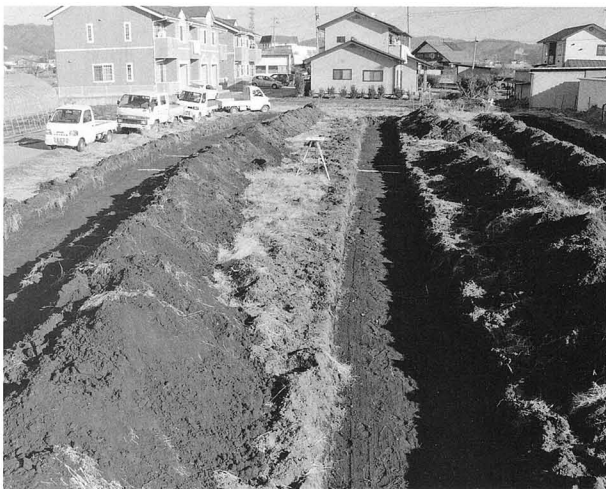
試掘トレンチ
