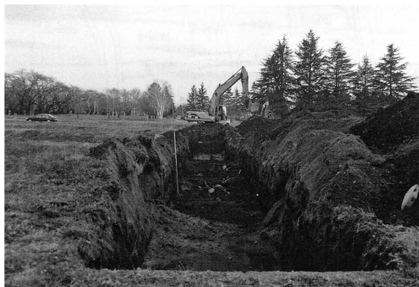
試掘トレンチ
