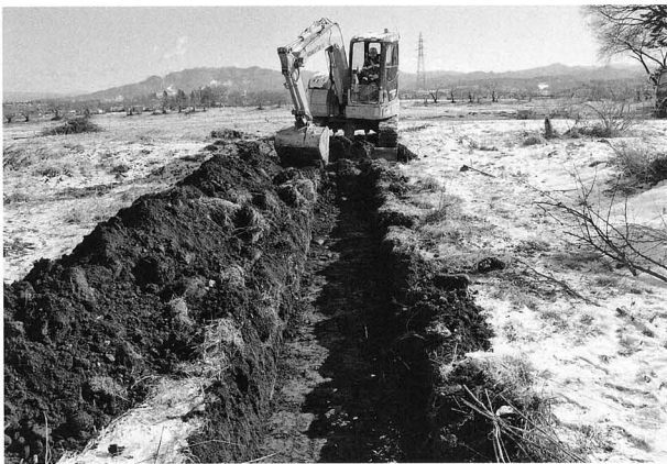
試掘トレンチ
