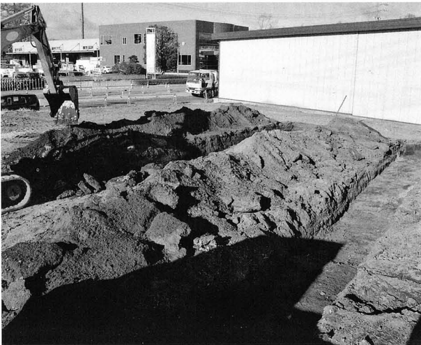
試掘トレンチ
