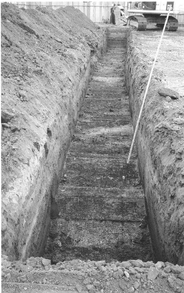
試掘トレンチ
