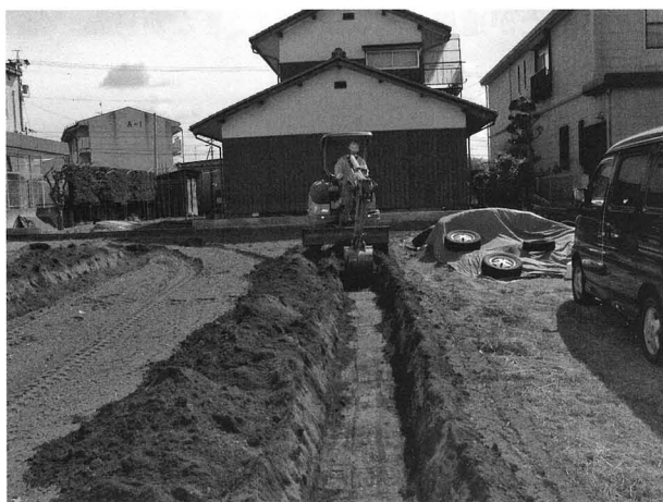
試掘トレンチ
