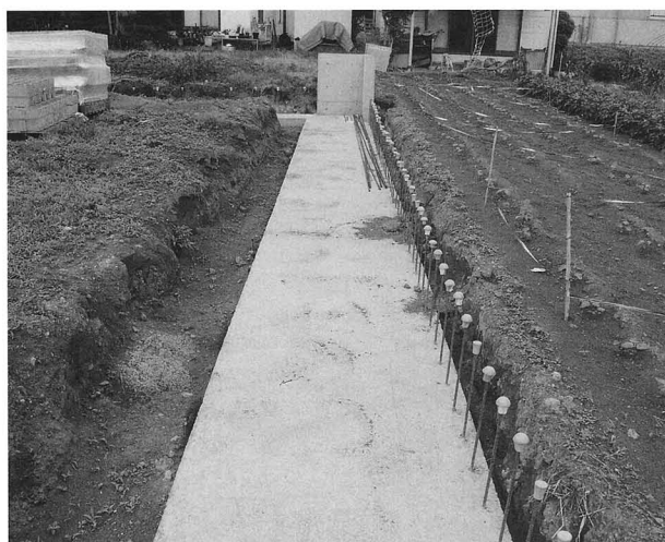
試掘トレンチ
