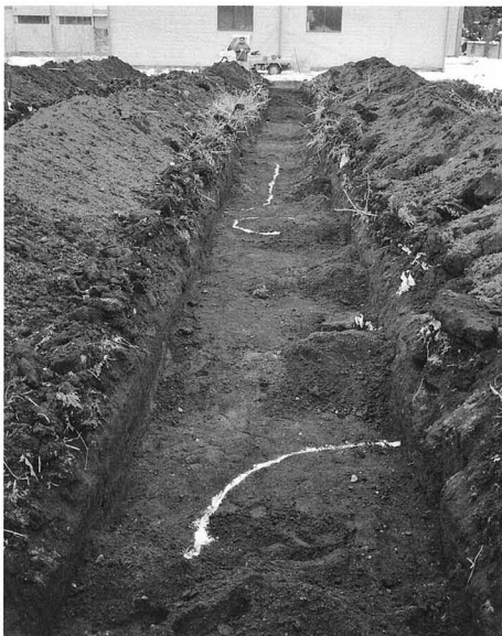
試掘トレンチ
