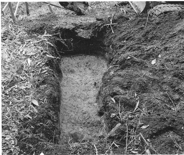
試掘トレンチ
