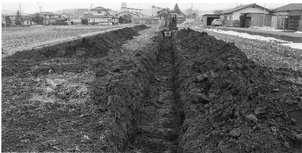
試掘トレンチ
