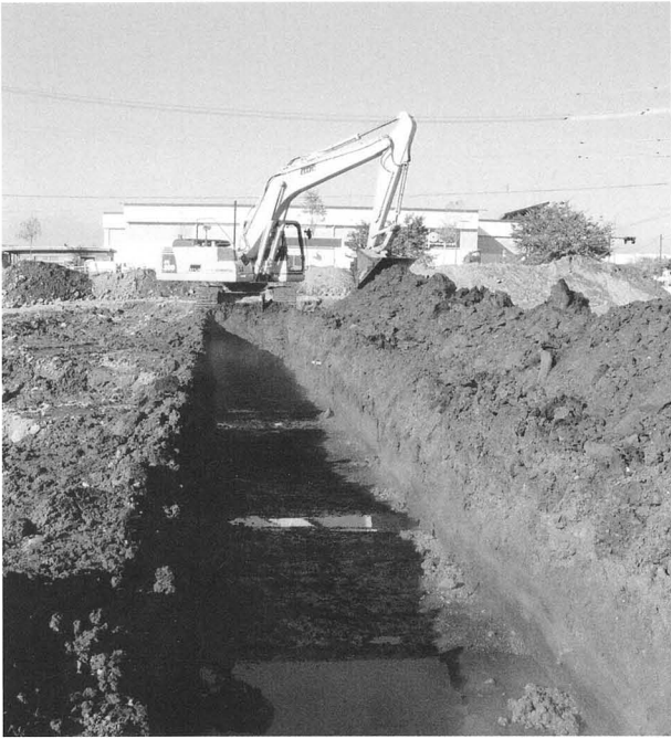
試掘トレンチ
