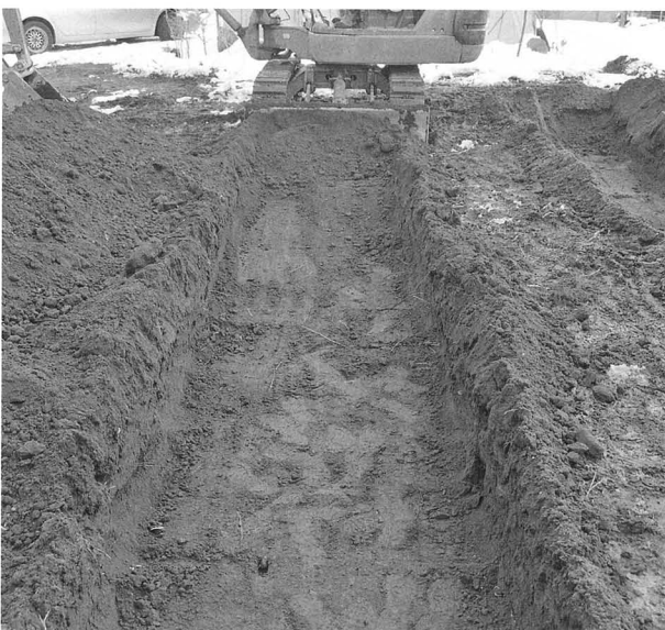
試掘トレンチ
