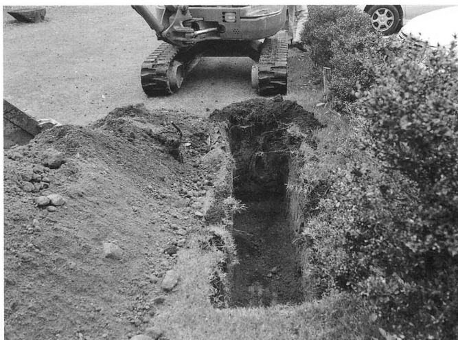
試掘トレンチ
