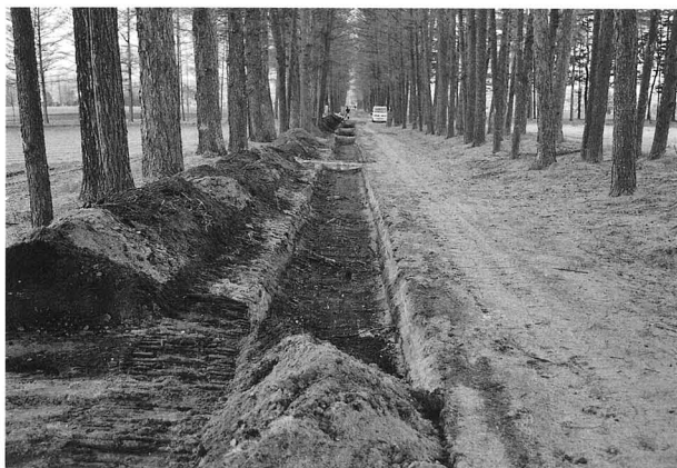
試掘トレンチ
