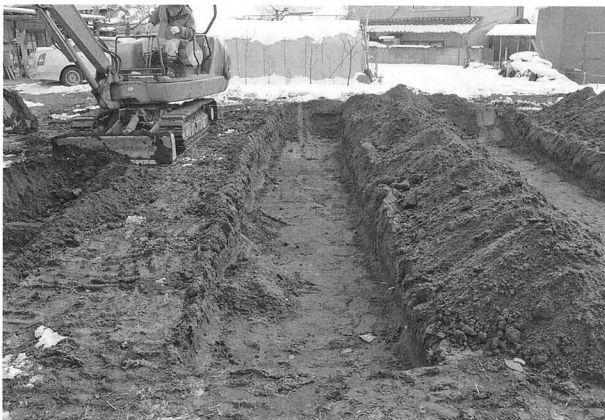
試掘トレンチ
