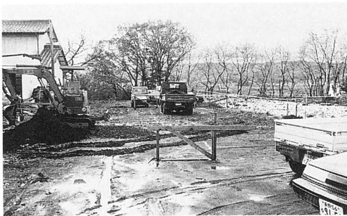
遺跡近景 (北方より)
