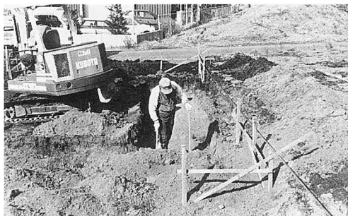
基礎工事作業状況（東方より）
