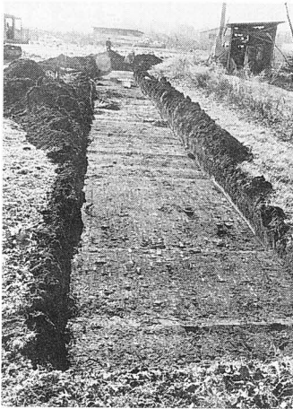
西側トレンチ全景
