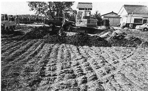
掘削近景 (東方より)
