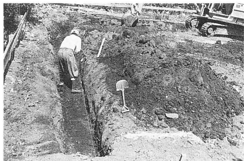
掘削近景 (西方より)
