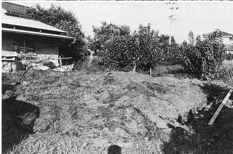
掘削全景 (南西より)
