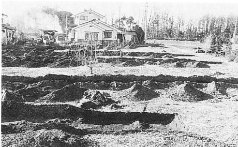
北側トレンチ全景
