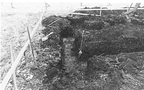
掘削近景 (西方より)
