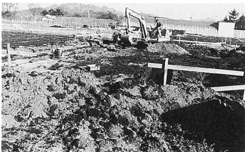
掘削近景(西方より)
