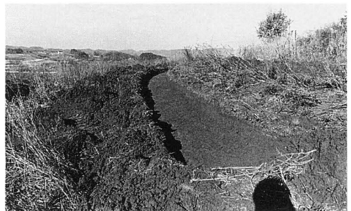
Cトレンチ全景（南方より）
