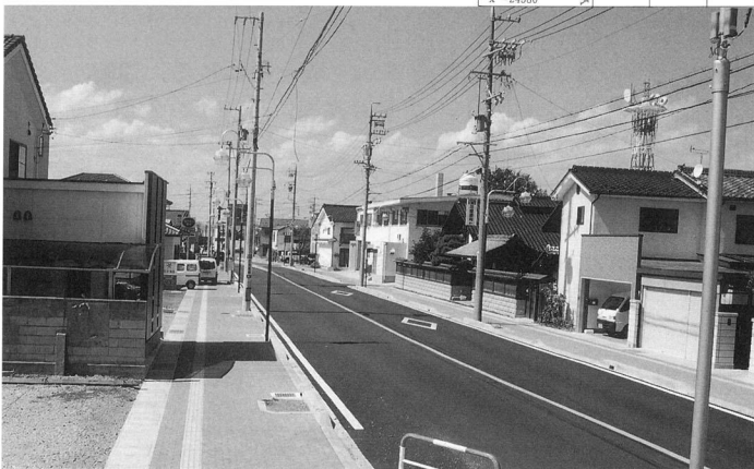
道路工事終了後風景21トレから北を望む
