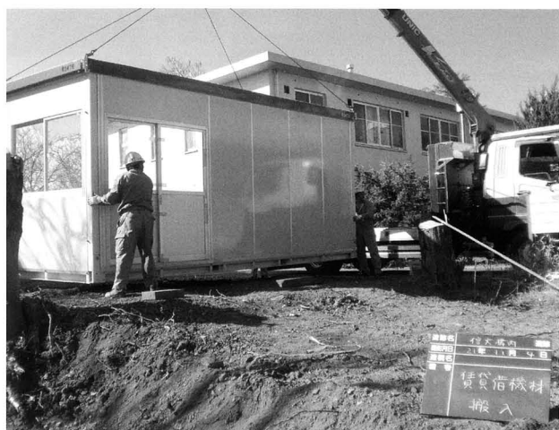
現場事務所設営
