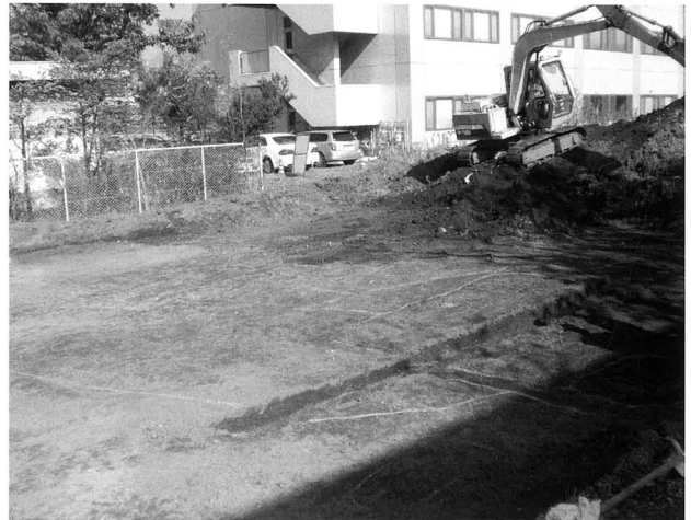
発掘調査 A 区表土剥ぎ進行状況
