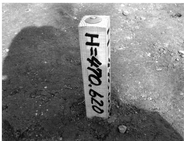
基準点杭 (BM) 設置状況
