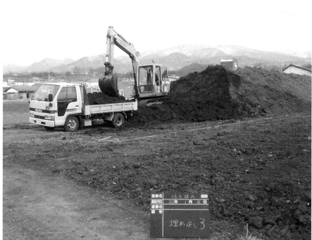
発掘調査 B 区埋め戻し完了状況
