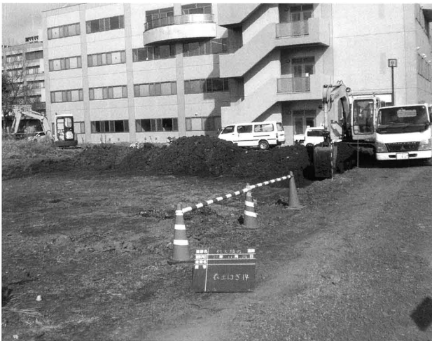
遺伝子実験棟東側表土剥ぎ状況
