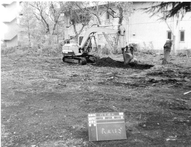
発掘調査 A 区表土剥ぎ着手状況
