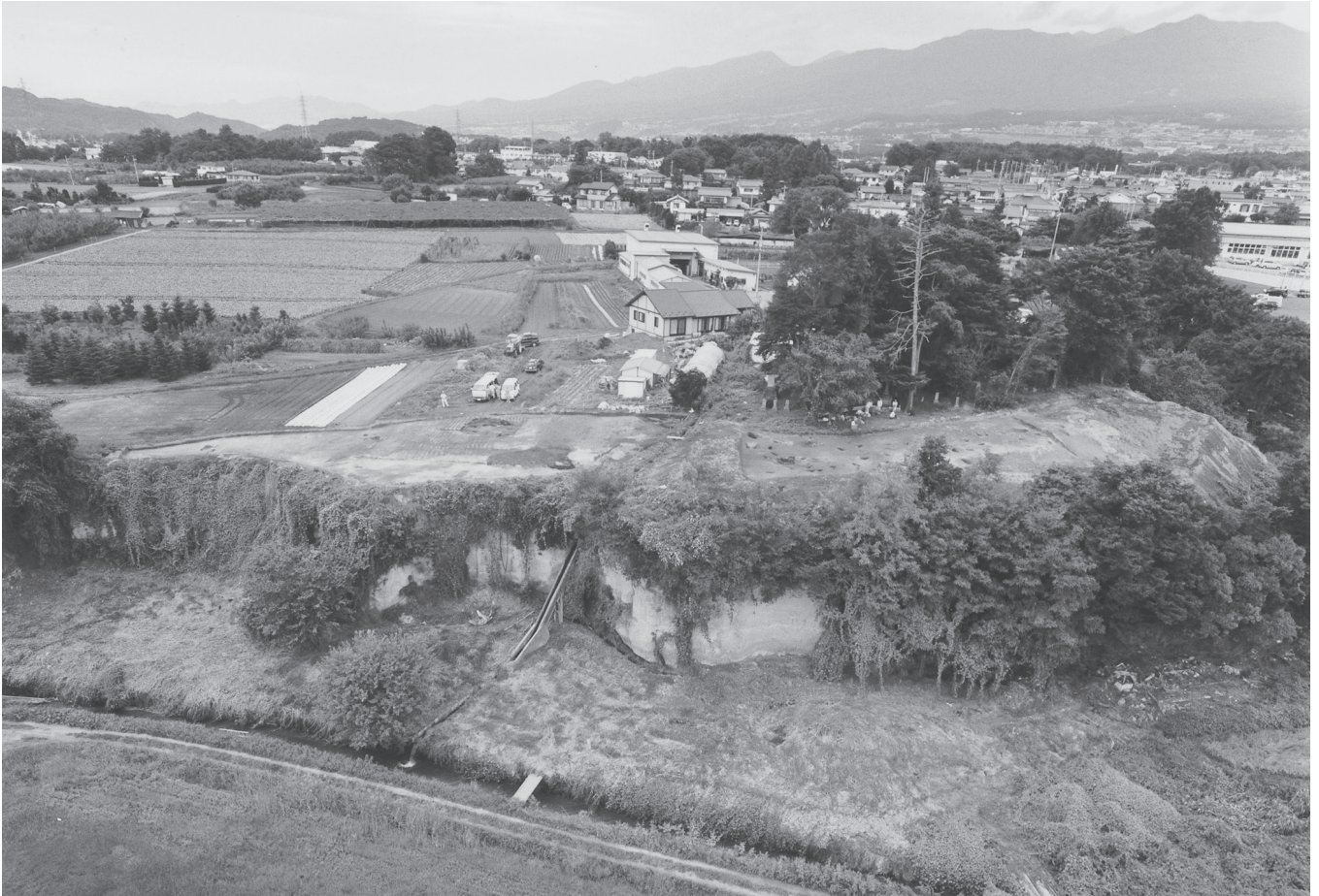
全景（南東より）
