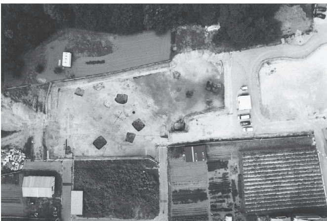
7区全景 (上空より)
