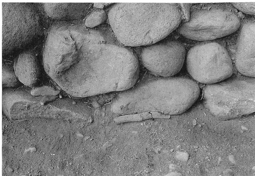
14→ 東面南側 土塁内部の 石積みと炭片
