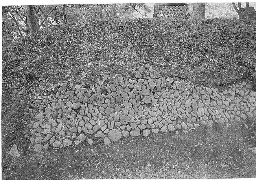
11↑ 東面南側 (90-06)の後世補修の石積み
