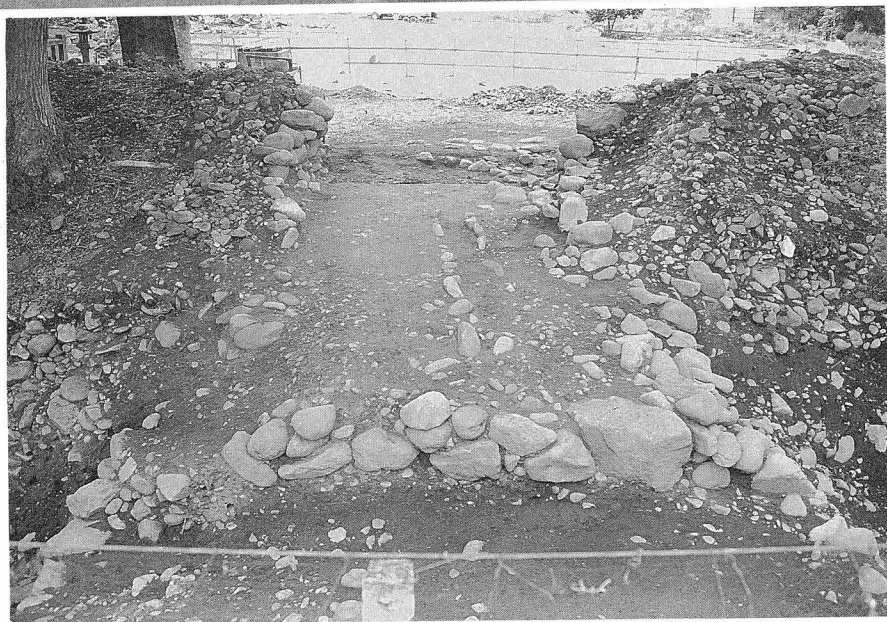
19→ 堀の外側 から見た東 入口土橋中 央の石積み
