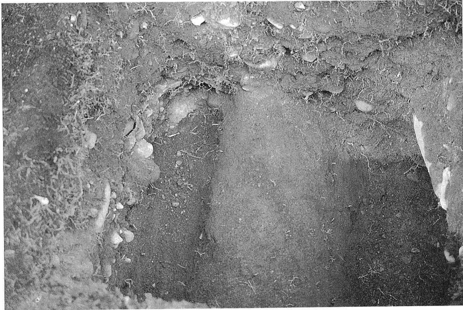
1↑ 築地塀の頂部(90-01)
