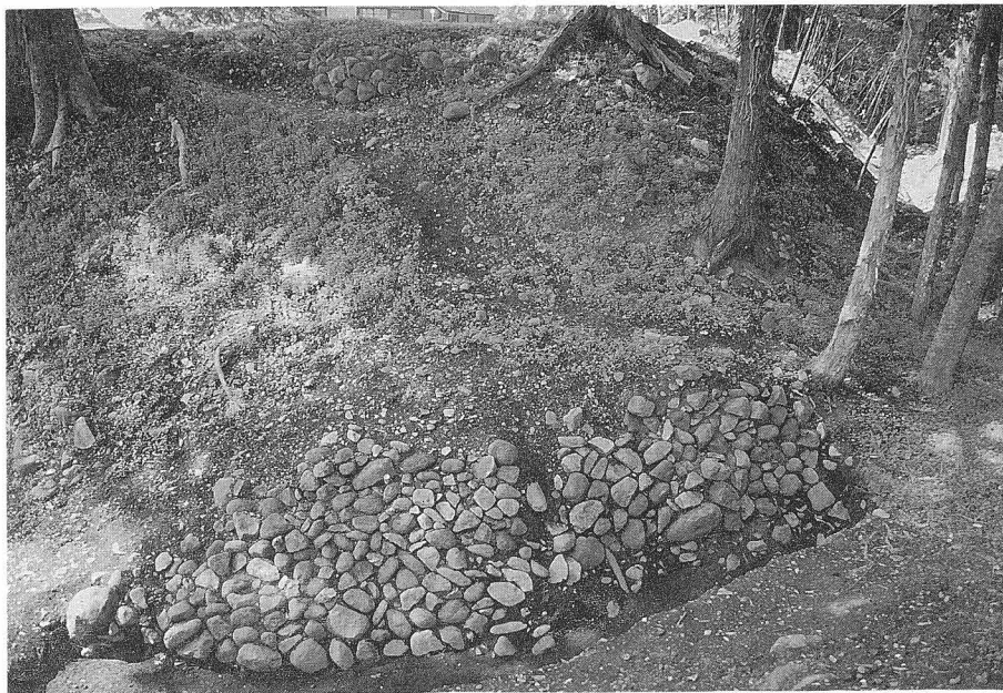
27 ↑ 北面東側 土塁外角の石積み (後世の補修か)
