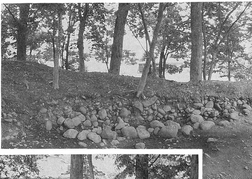
12→ 南面の 土塁内部
