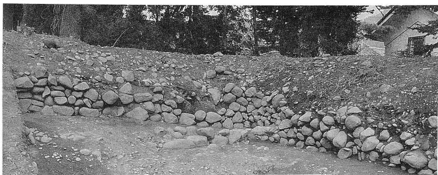
29→ 北面東側土塁 (90-15)内角の 石積み
