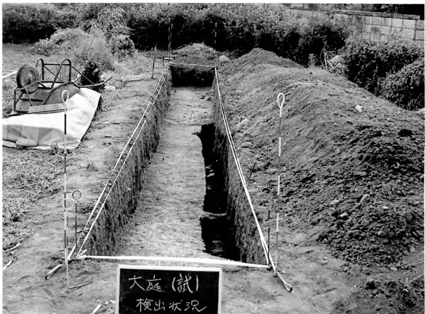
トレンチ完掘状況
