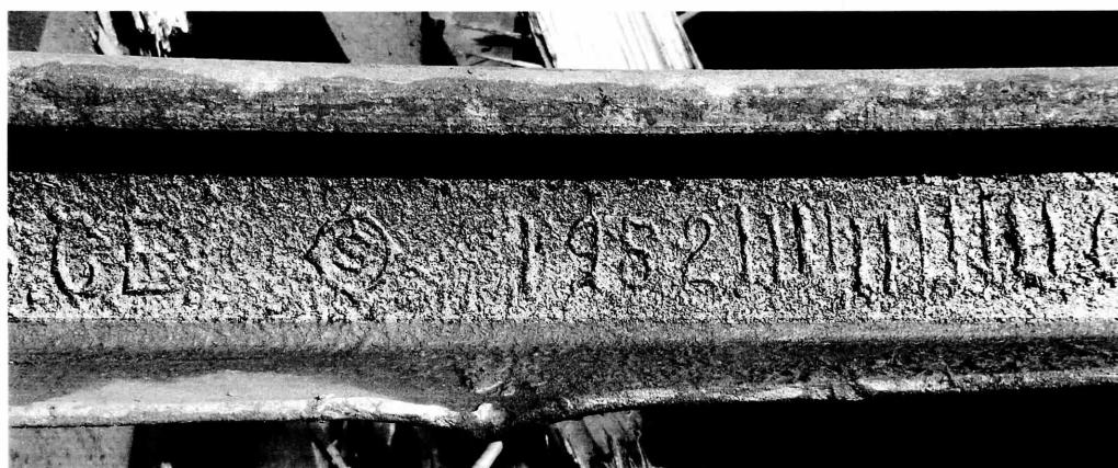
[写真 27] ホイストクレーンのレールの刻印「A.S.C.E. 1952」※該当箇所のコントラストを変えている
