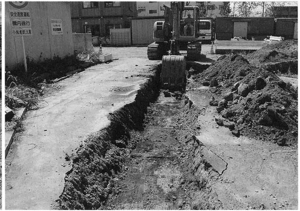
M1号溝址 重機による表土削平
