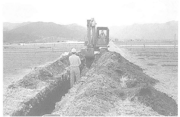
重機による表土除去作業
