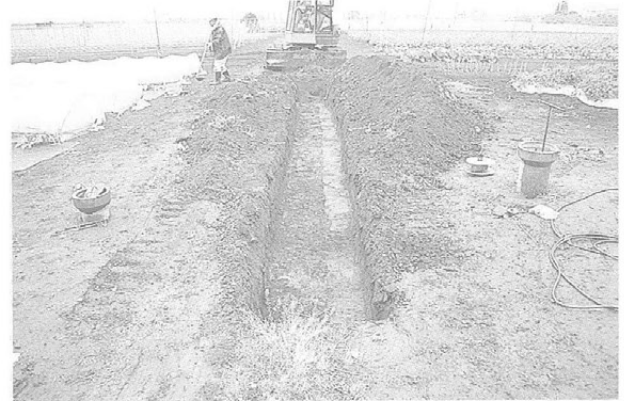
下原遺跡第5トレンチ (西から)
