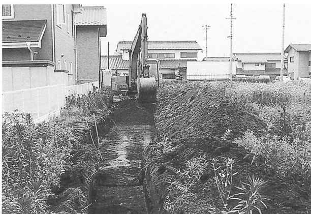
調査状況 (北より)
