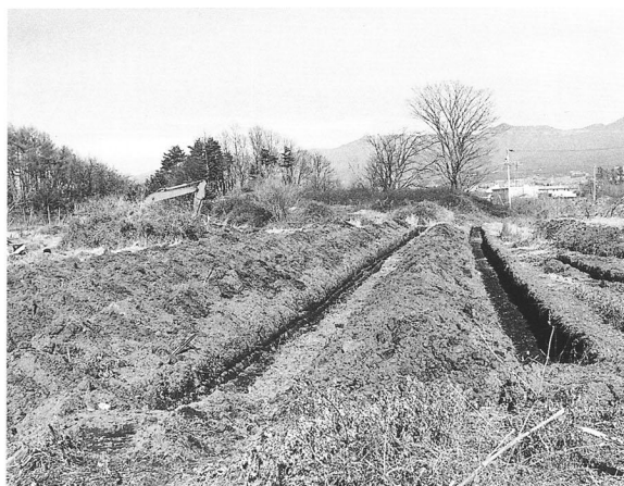
調査状況 (南から)
