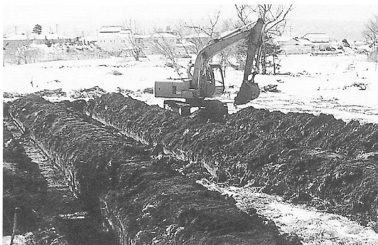
調査状況 (北より)
