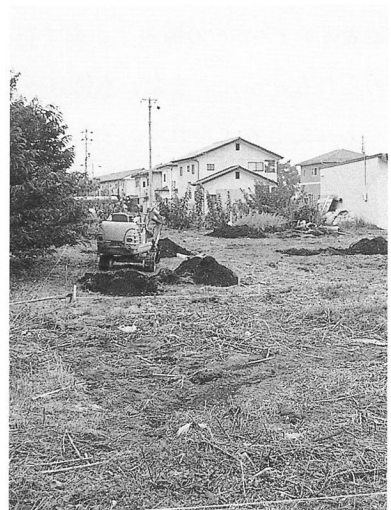
調査風景 (西から)
