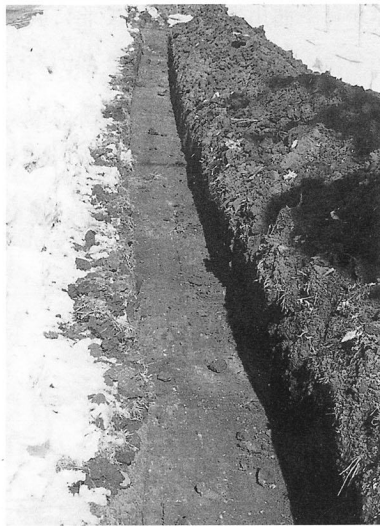
トレンチ掘削状況
