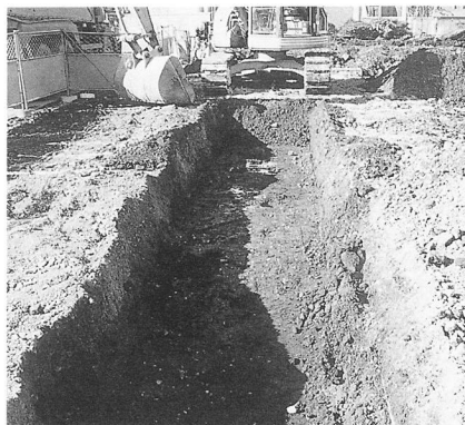
トレンチ掘削状況 (東より)
