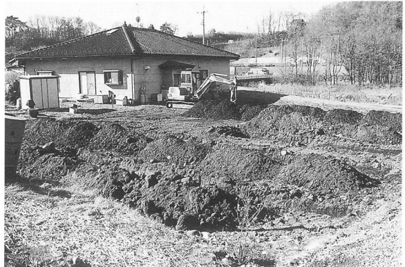
調査状況 (北から)
