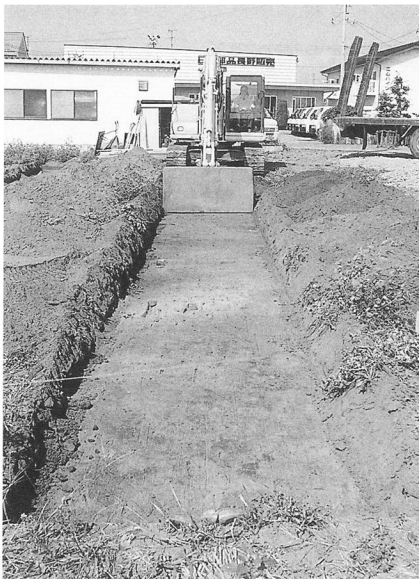
調査風景 (西から)
