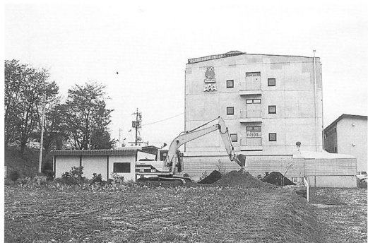
調査風景 (西から)
