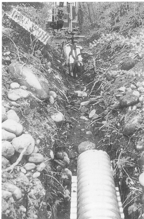
4. 四の堀水路設置状況
