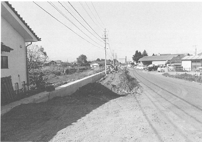
新町遺跡 2 調査地点近景 (南西方から)
