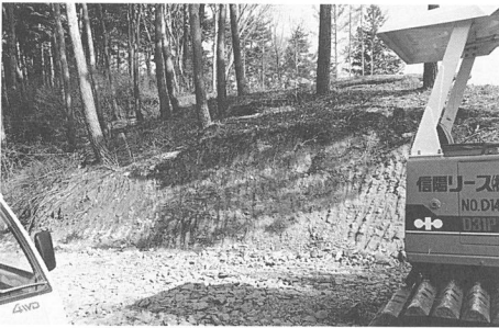
平賀城跡1調査地点近景（南方から）
