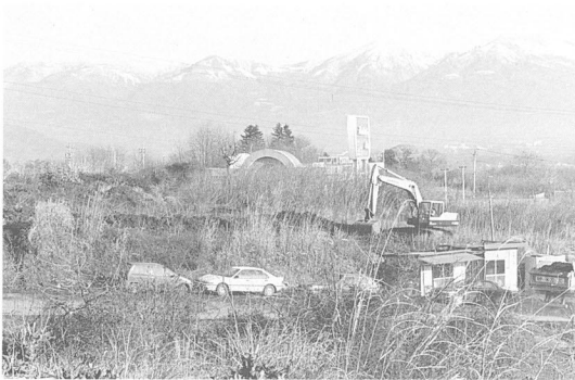
立石遺跡3 第11トレンチ遠景（南方から）
