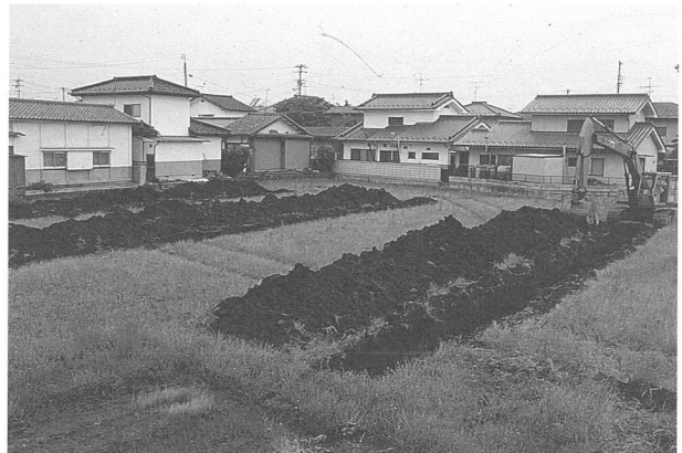
宮の後遺跡 1 調査地点近景 (北方から)
