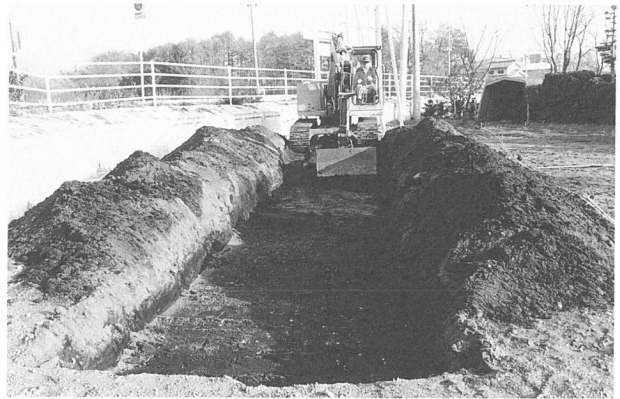
芝宮遺跡群3調査地点近景(北方から)
