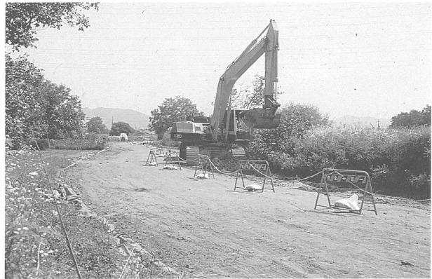
西一本柳遺跡II調査地点近景 (西方から)
