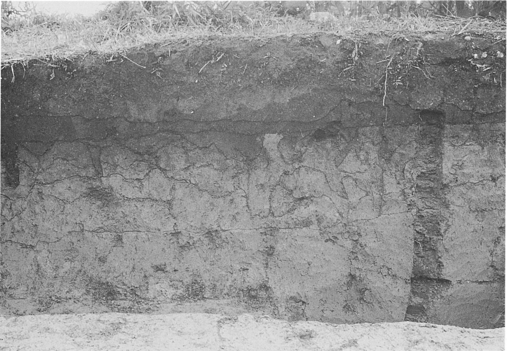
5. 調査区の層序 (C-7区) (東から)
