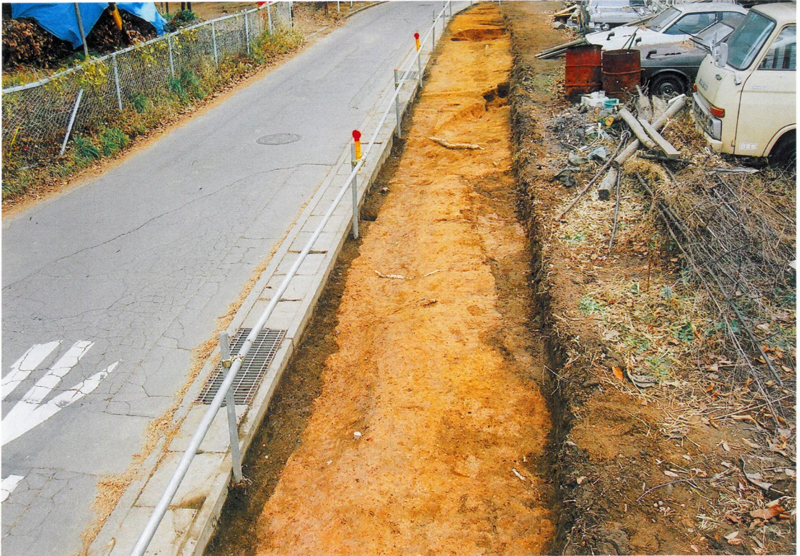
Sトレンチ全景(西より)
