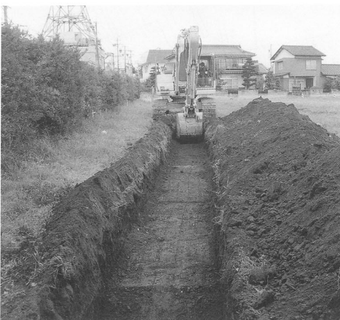
試掘トレンチ
