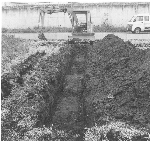
試掘トレンチ
