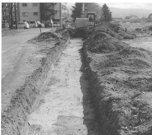
試掘トレンチ
