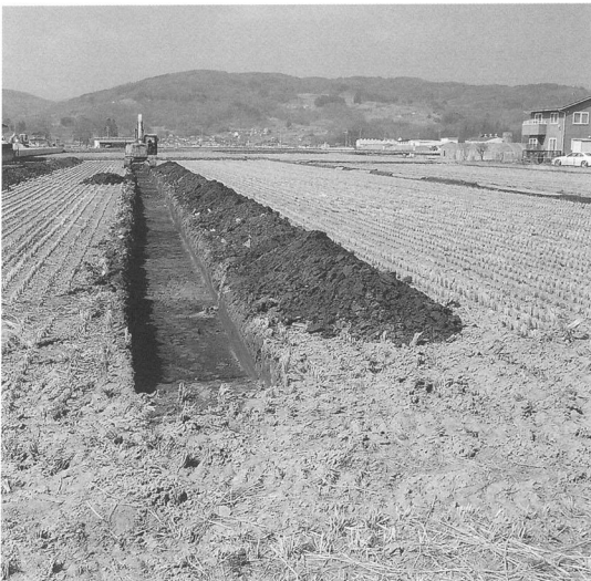
試掘トレンチ
