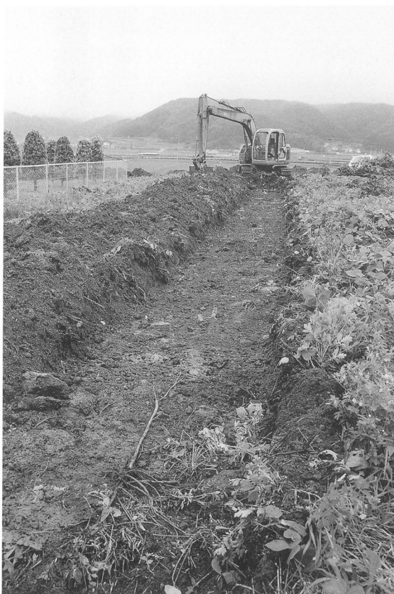
試掘トレンチ
