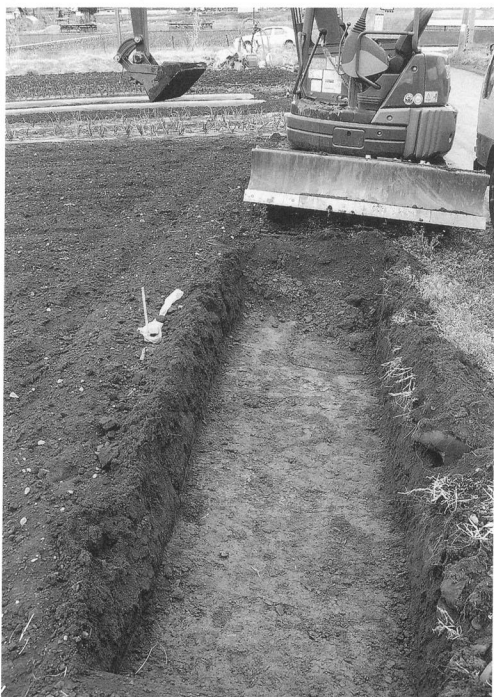
試掘トレンチ
