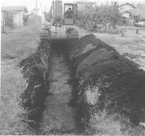
試掘トレンチ
