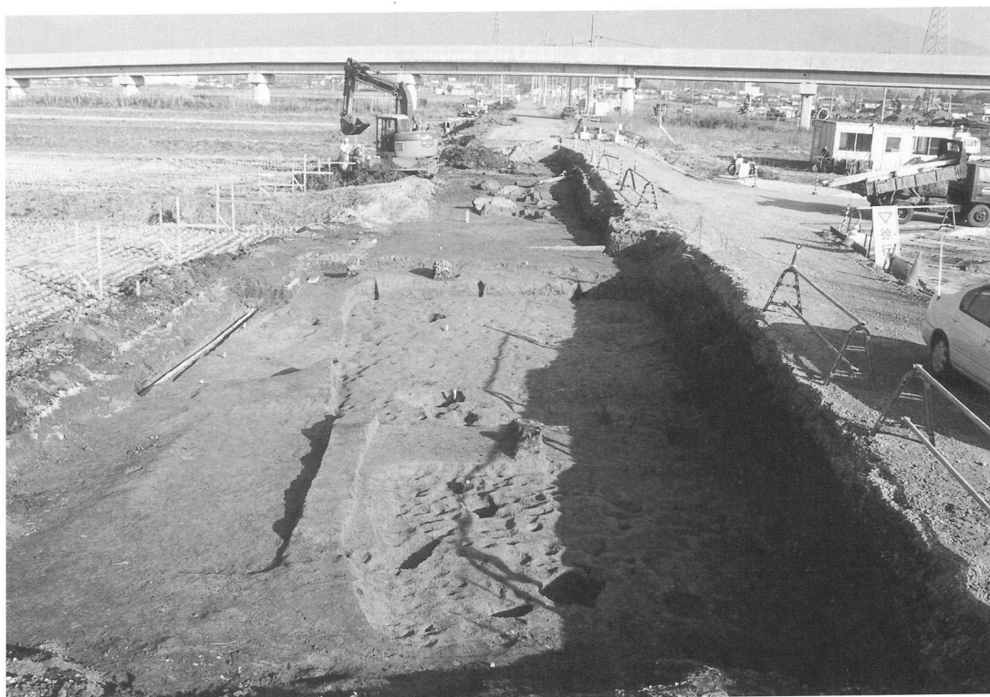
辻の前遺跡Ⅱ H1・H2号住居址付近
