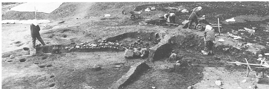
②礫群址検出状況
