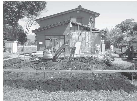
御料遺跡 工事立会
