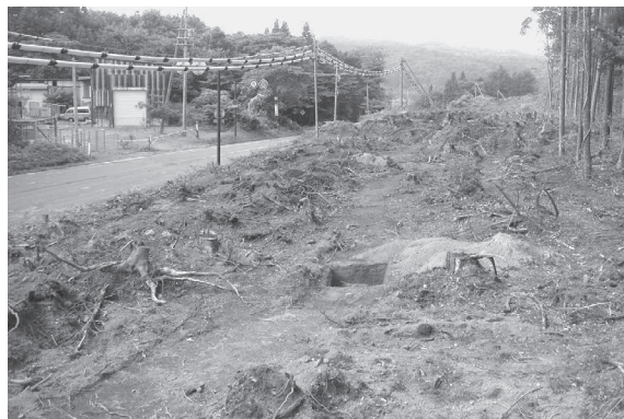
6. 国道18号野尻バイパス道路改良予定地 IV区完掘状況
