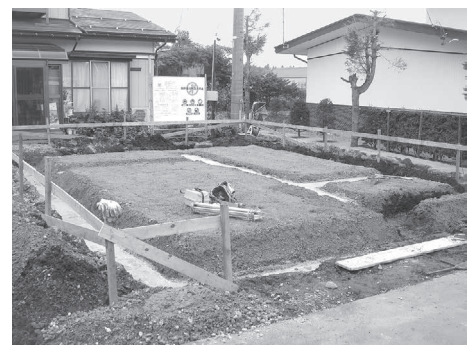
御料遺跡 工事立会
