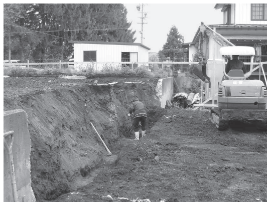
海端遺跡 工事立会
