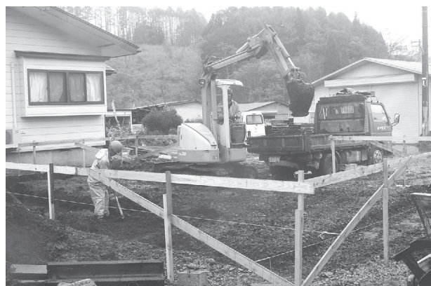
東裏遺跡 工事立会
