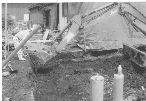
川久保遺跡 工事立会
