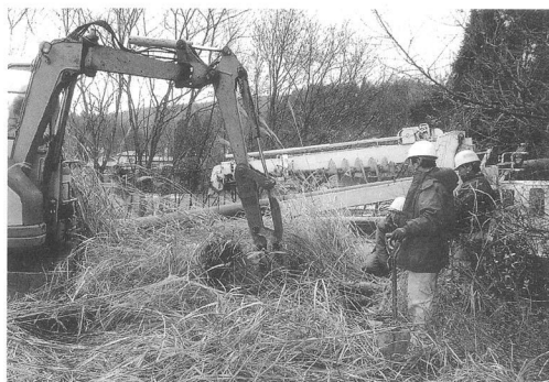
高山遺跡 工事立会
