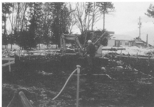
小丸山公園遺跡 工事立会
