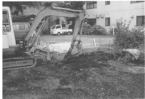
立が鼻遺跡 工事立会
