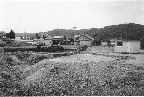
調査地区埋め戻し状況
