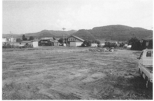
調査地区埋め戻し完了状況
