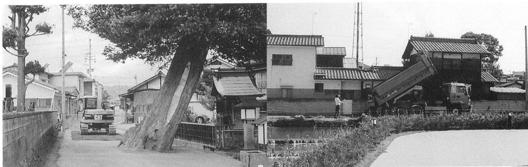
調査第⑥西区 埋め戻し状況（東より）
