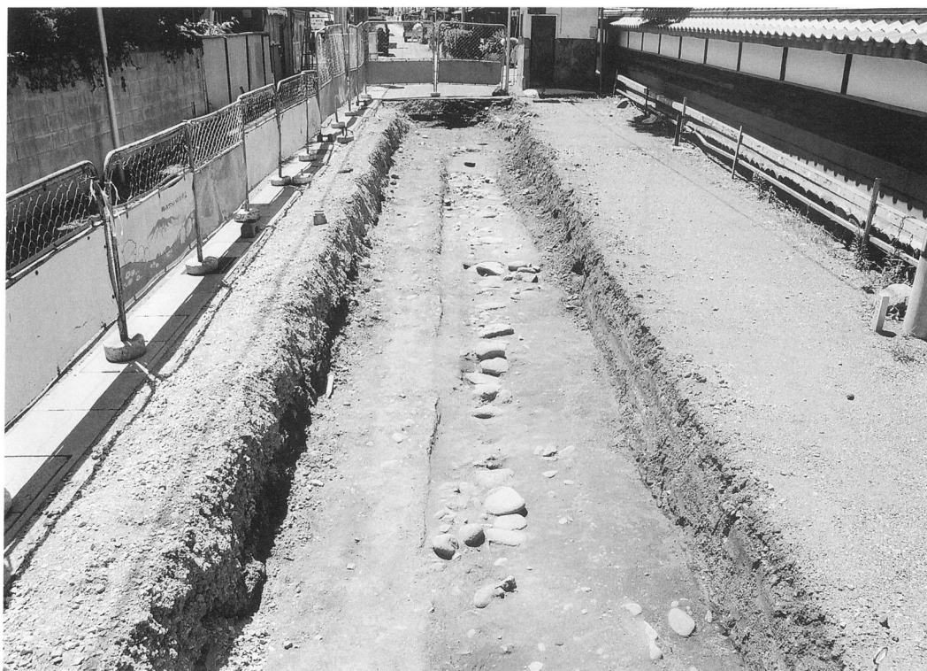
調査第①区 S1号石組遺構検出状況（北より）
