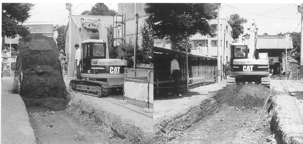
調査第①区 土砂埋め戻し状況（運搬）
