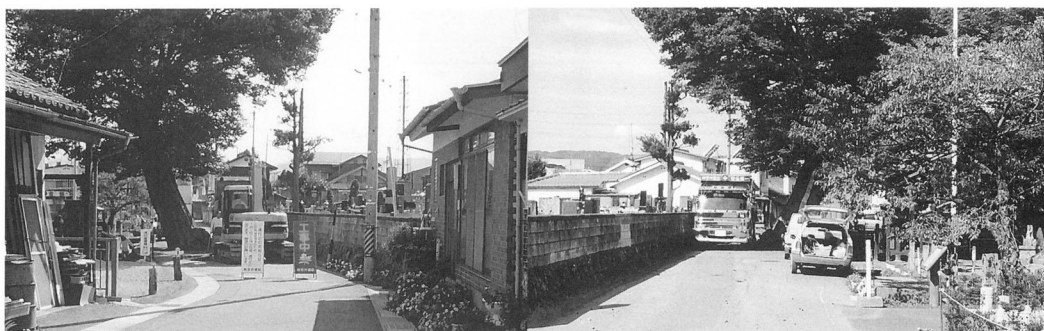
調査第⑥西区 表土掘削状況（西より）
