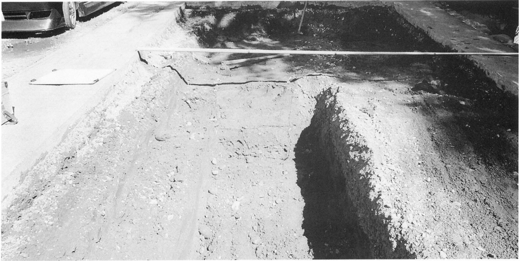
調査第⑦東区 土層・遺構確認状況（西より）
