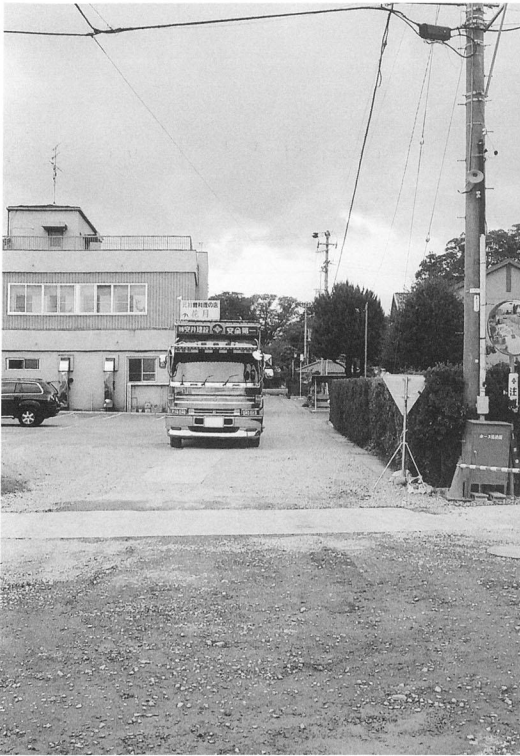
調査第④区 土砂埋め戻し状況（東より）
