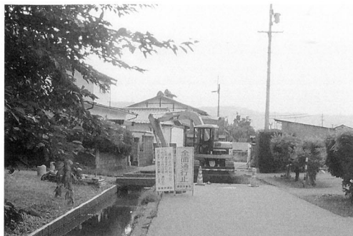
調査第⑦西区 埋め戻し状況 (東より)
