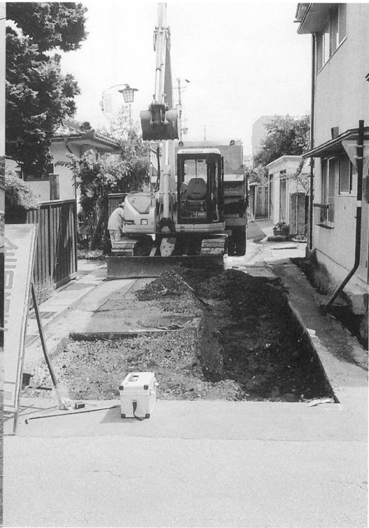
調査第⑤区 表土掘削状況（西より）
