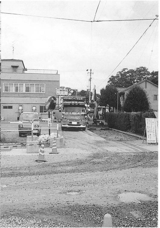
調査第④区 表土除去・土砂運搬状況
