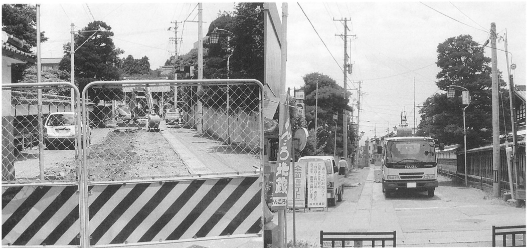
調査第①区 表土除去作業
