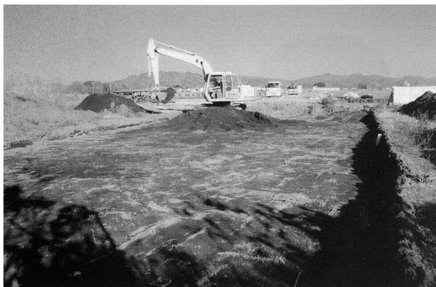
重機で表土を除去するー平成 21 年度ー (西から)
