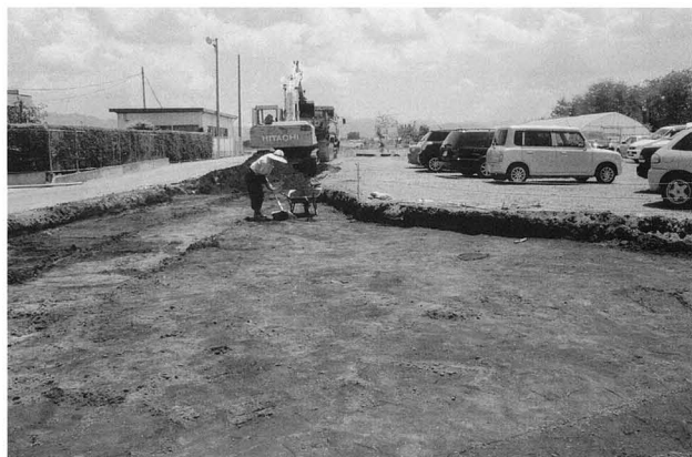
重機で表土を除去するー平成 22 年度ー (西から)
