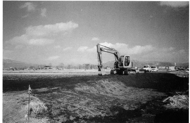
埋め戻し状況
