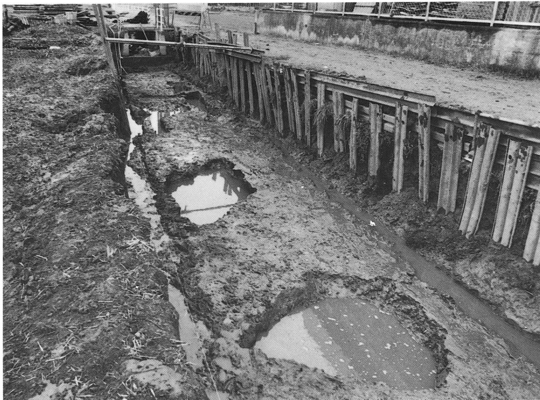
a. トレンチ北半完掘状況
