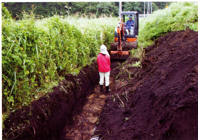
トレンチ表土掘削（北より）
