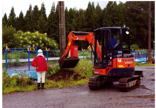
テストピットの表土掘削（南東より）
