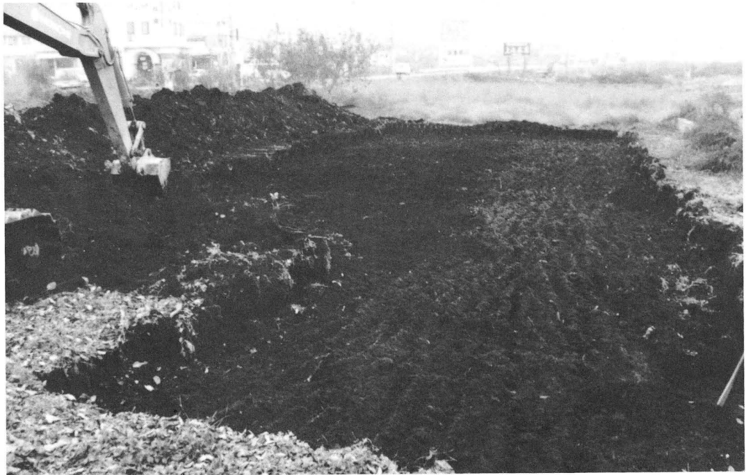
バックホーによる表土除去
