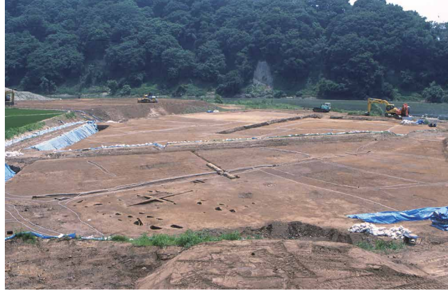
左：川久保SD41・ 42完掘状況（北より） 右：川久保1区2面 水田跡北部完掘状況 （北より）
