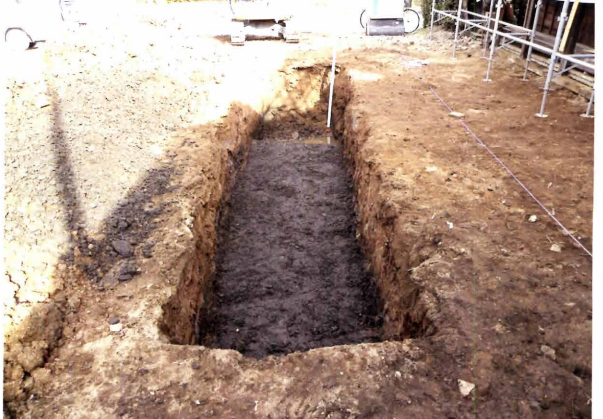
トレンチ完掘（南から）
