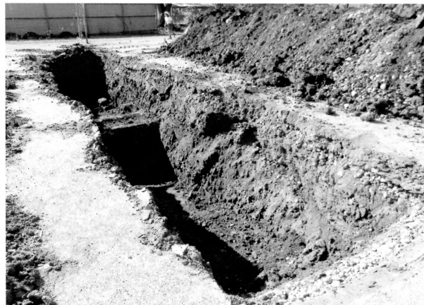
8号トレンチ検出状況（北東より）
