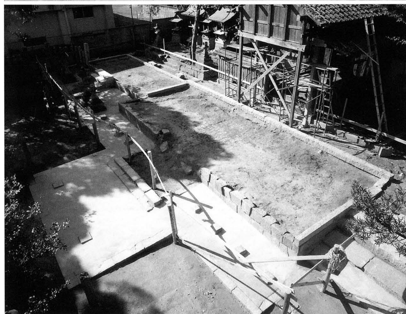
調査前拝殿基壇（北東から）
