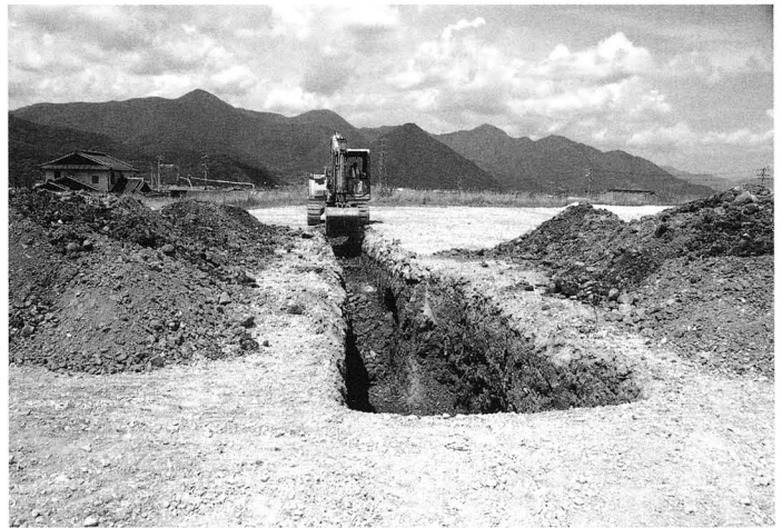
トレンチ掘削状況 (東より)
