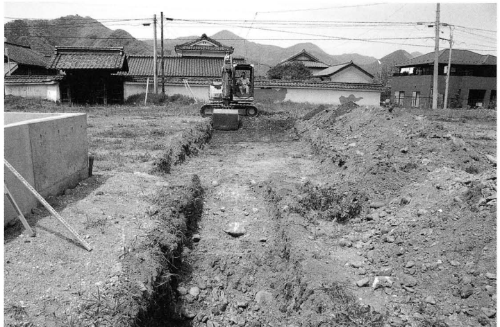
トレンチ掘削状況 (東より)
