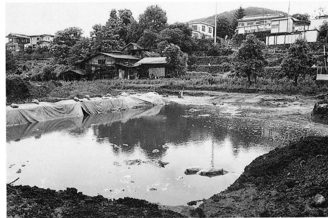
谷部水没状態 (平成7年7月)
